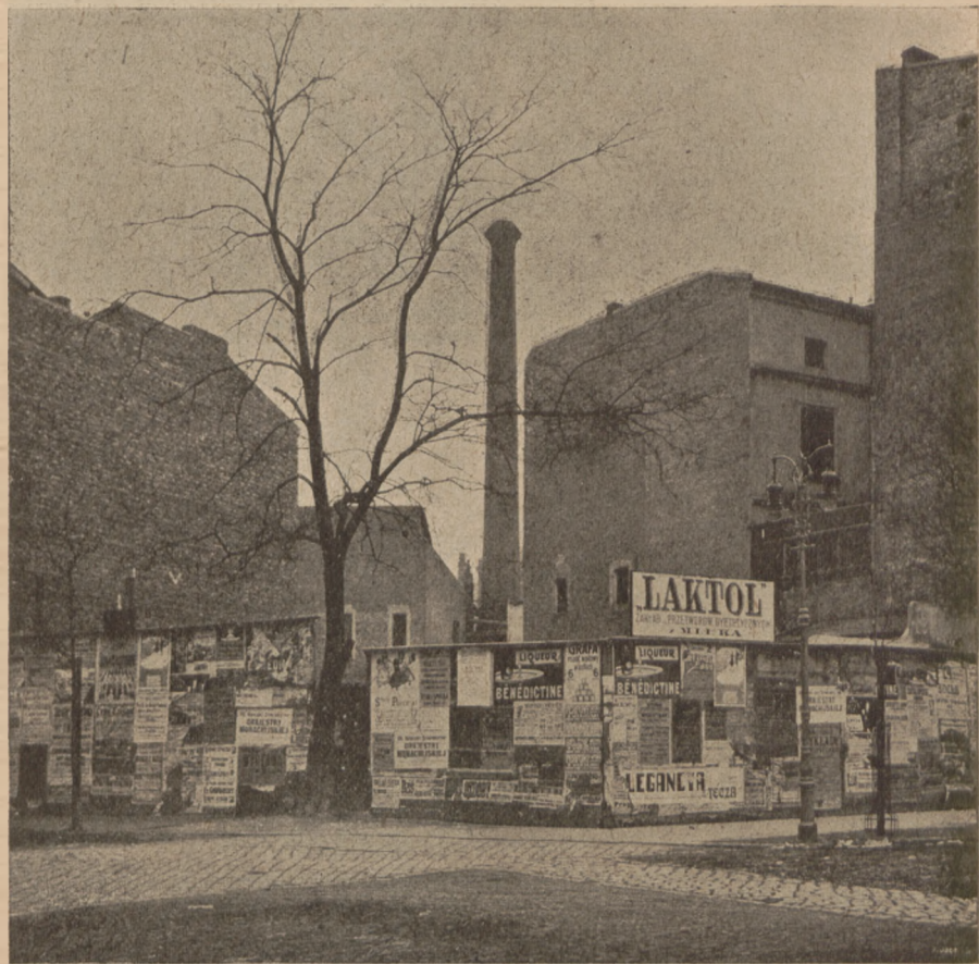
Obecny stan po zburzeniu baszty.
