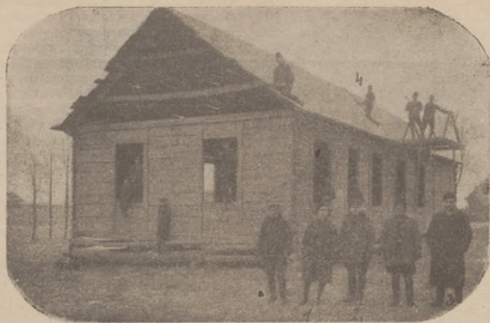
KOŁO MŁODZIEŻY PRZY PRACY. i Budowa Domu Ludowego przez Koło Młodzieży Wiejskiej w Krasieninie z. Lubelskiej.
