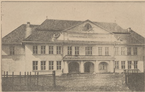
Janowice — budynek szkolny.
