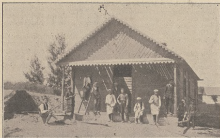
Dom Ludowy w Skrzynicach w budowie. (obecnie już wykończony).
