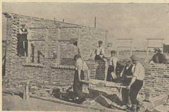
Młodzież Wiejska buduje dom ludowy w Kol. Dembe.
