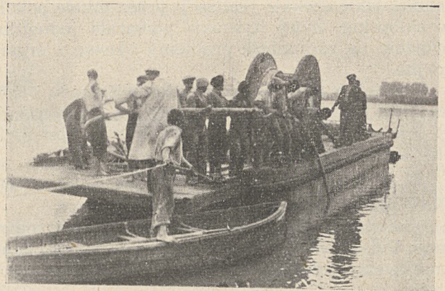
Zakładanie kabla w wodzie
