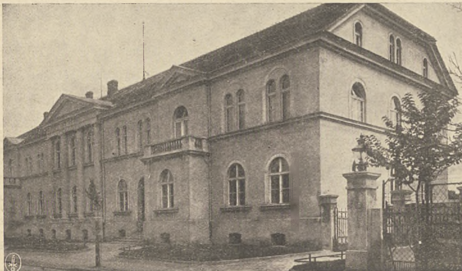
Przebudowany w roku 1929 budynek administracyjny powiatu Środzkiego, w którym się mieści Starostwo, Wydział Powiatowy i Komunalna Kasa Oszczędności
