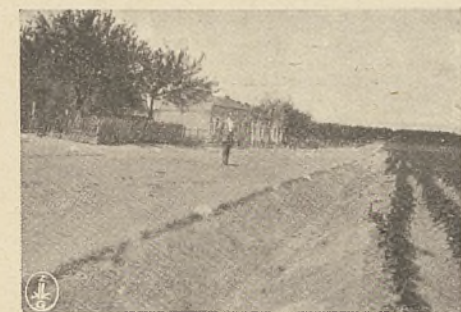
Uregulowana droga gruntowa w pow. Strzełińskim.
