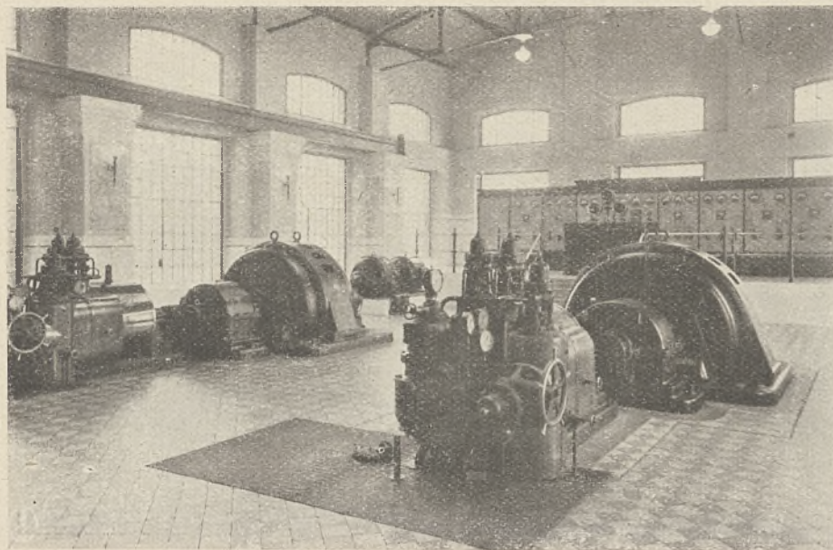
Hala turbin parowych w cukrowni Kościańskiej
