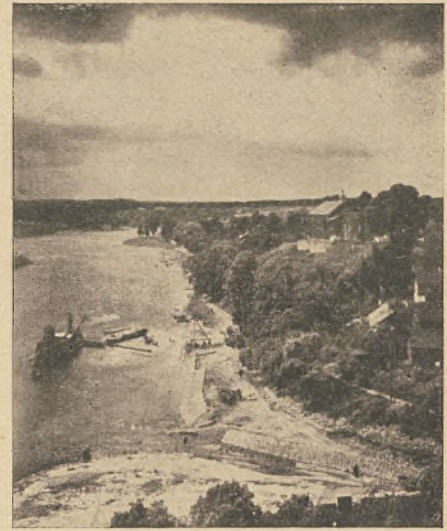
Budowa bulwarów przy prawym brzegu Niemna w Grodnie.
