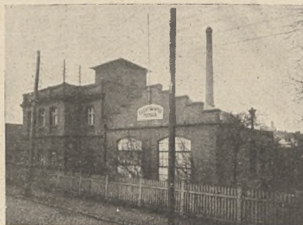
Elektrownia Miejska w Grodzisku-Wielkopolskim.
