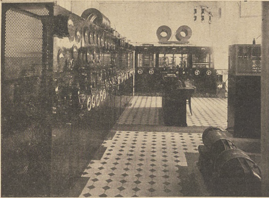
Aparatura 5-cio kilowatowej radiostacji w Gdyni, wykonana przez Państwową Wytwórnę Łączności.
