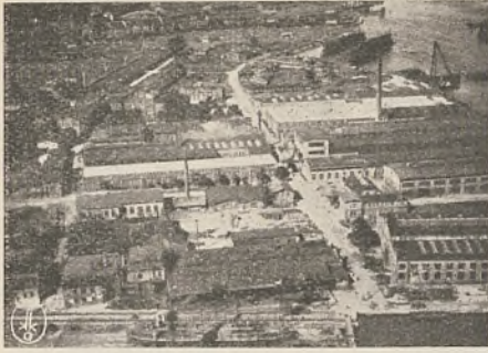
Stocznia Gdańska -- Widok ogólny.
