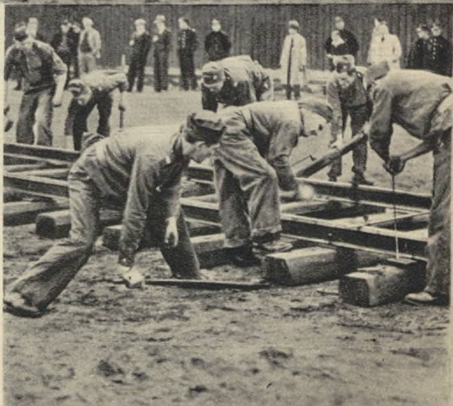
Trójbój wojskowo - kolejowy KPW. Konkurencja techniczna: układanie i rozbiórka przęsla z szyn.
