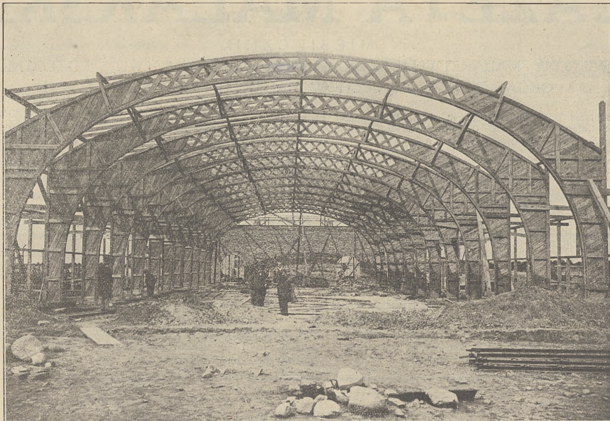
Fragment Pawilonu Wystawowego PWK. w budowie
