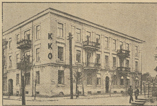
Nowa siedziba K. K. O. pow. Płockiego (Plac Marsz. Piłsudskiego 2).
