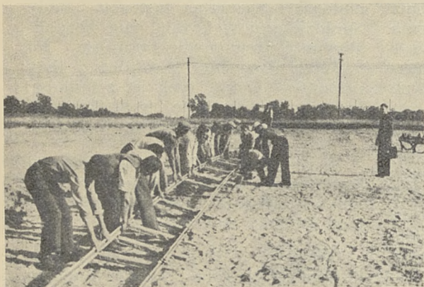
Przesuwanie toru o szerokość zwaliki przy niwelacji terenu pod IV Kolonię Ogródków Działkowych na Powązkach
