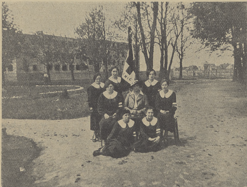
Wgłębi budujący się nowy gmach zakładowy...
