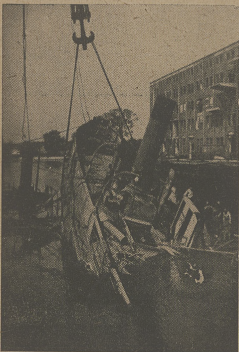
Usuwanie zniszczeń to I etap naszej pracy. Podnoszenie statku „Borussia” w basenie stoczni elbląskiej.
