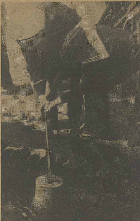
Spuszczanie materiału wybuchowego do luku.
