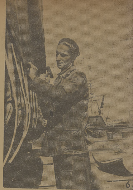
Ex niemiecki statek „Preussen” w trakcie przebudowy.
