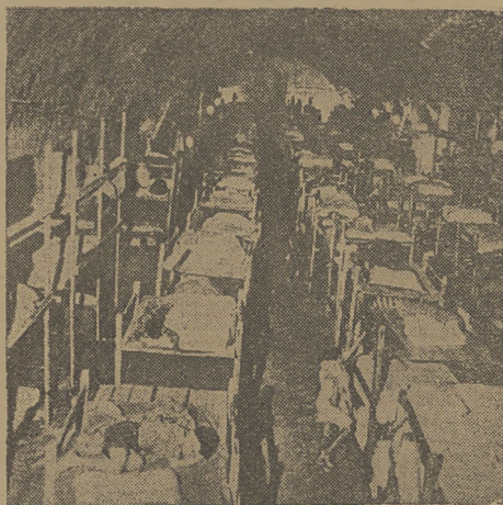
Podziemne korytarze wykute w skałach Malty.
