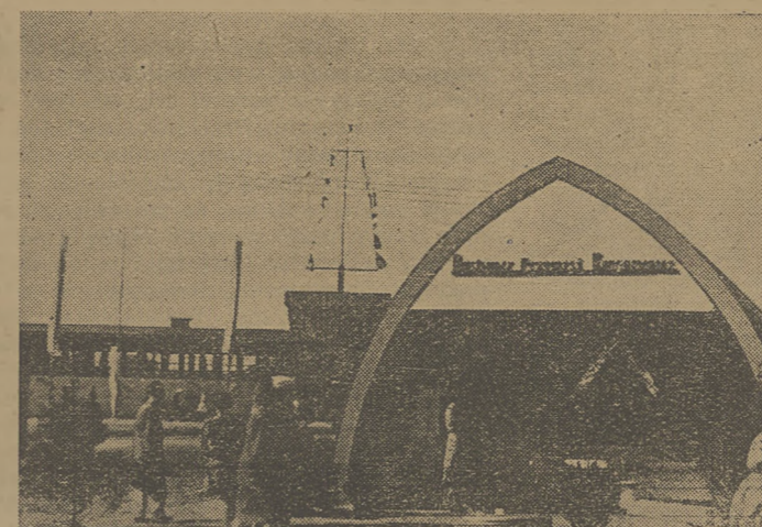
Produkty przemysłu konstrukcyjnego mieściły się w osobnym pawilonie.
