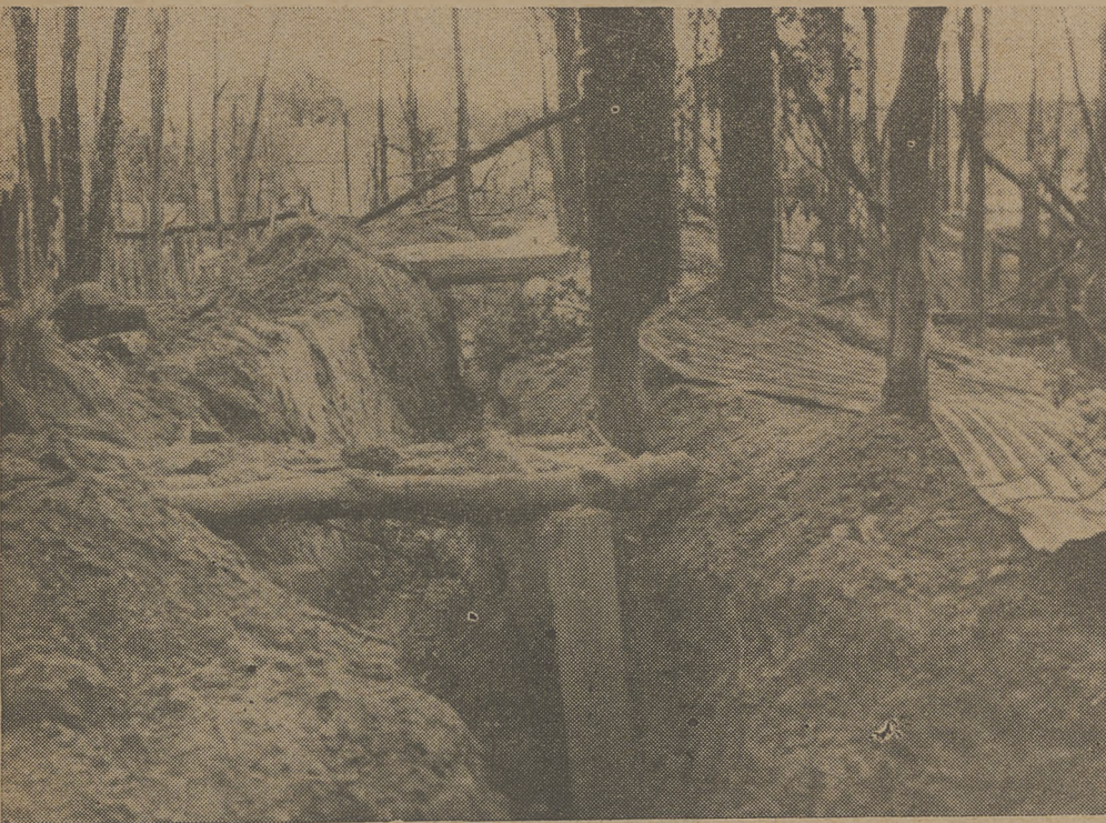
Zamiast betonowych, masywnych bunkrów nieprzyjacieli spotykał na drodze swego pochodu prowizoryczne w pośpiechu budowane okopy.
