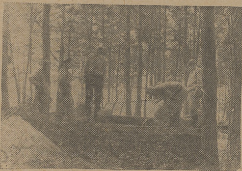
Już po rozpoczęciu wojny w szeregu miejsc budowano bunkry z drewnianych belek.
