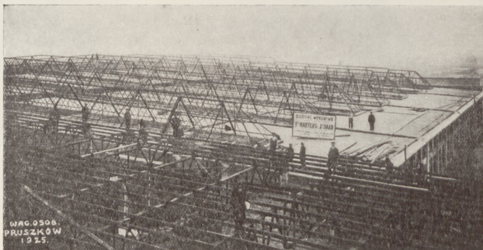
Konstrukcja dachu na tejże wagoniarni osobowej w Pruszkowie. Budowę wykonała firma Martens i Daab.
