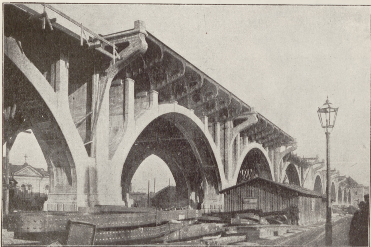
Fot. 10. Ustrój wapornikowy chodników wiaduktu.
