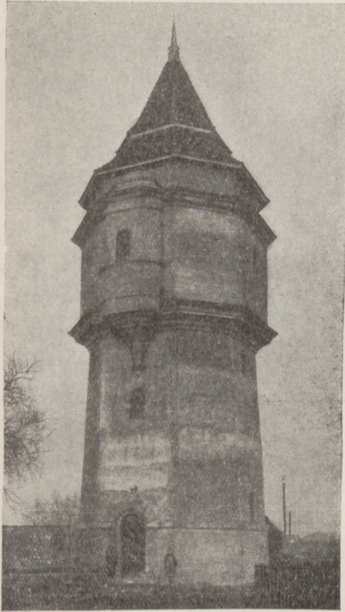
Wieża cieżień na st. Łódź-Kaliaka. Bud. wyk. firma Paweł Holc i S-ka.
