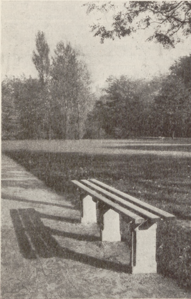
Ławka w ogrodzie miejskim im. J. Poniatowskiego w Łodzi. Podstawy ma ona betonowe, wierzchy zaś zrobione są z listew drewnianych, przykręconych śrubami, zapuszczonymi w beton.
