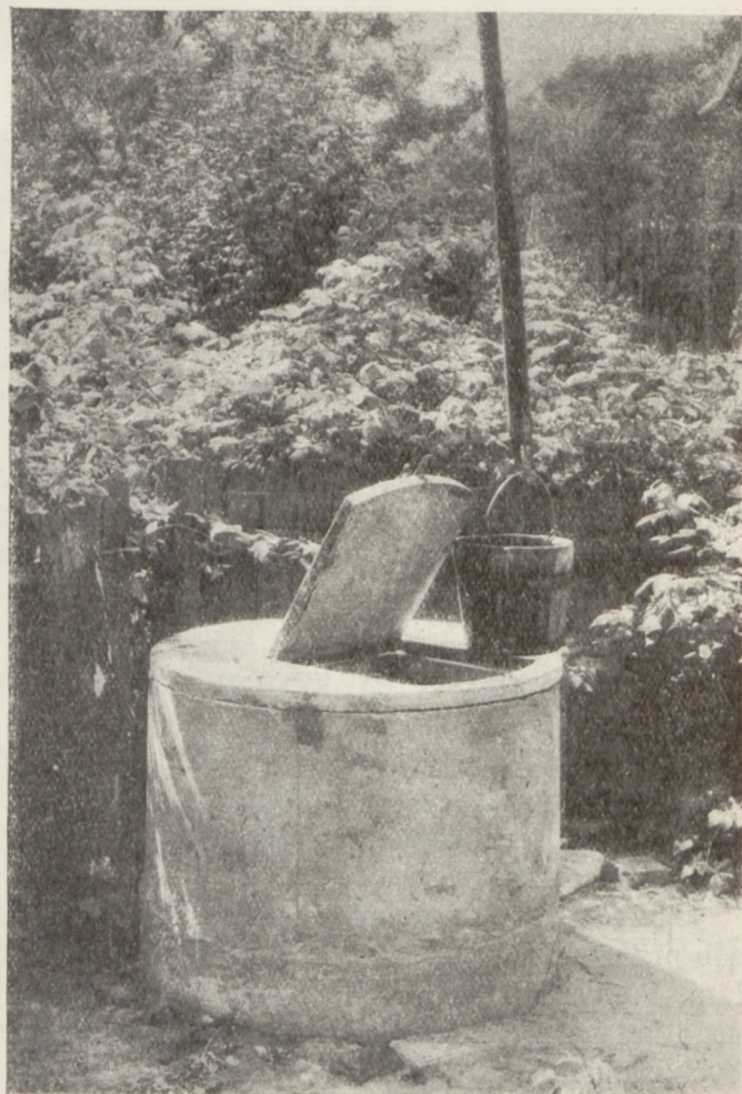
Studnia z kręgow na działce prof. Wachowskiego, w Milanówku pod W-wą. Betonowa przykrywa, obramowana kątownikiem żelaznym na zawiasach. Wykon. p. Wacław Pióro, w Milanówku.
