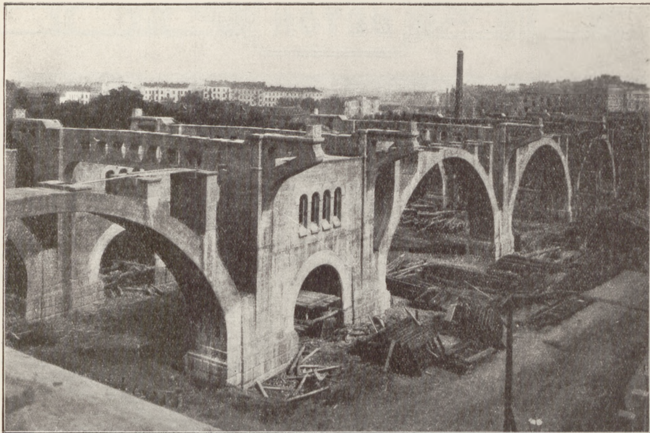
Fot. 9. Filary przyczółków i belki arkadowe wiaduktu.
