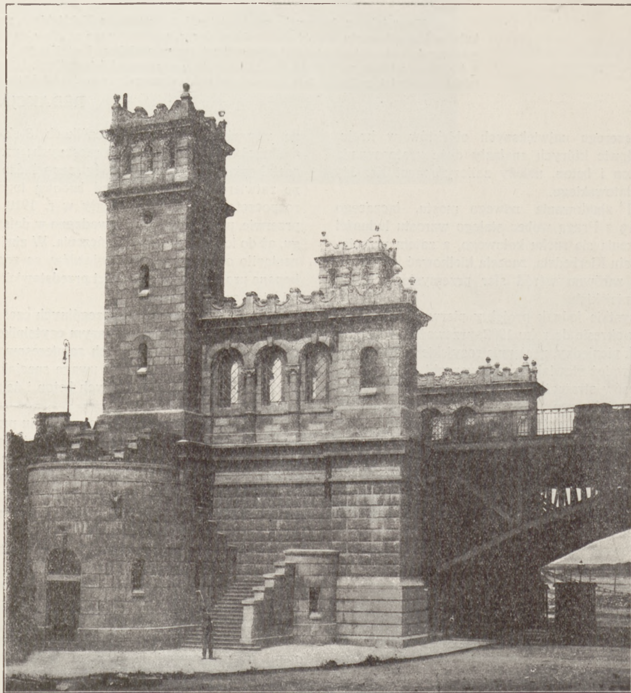
Fot. 1. Strażnice mostowe na przyczółkach.
