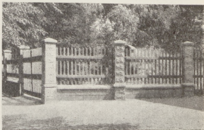
Ogr. dzenie parceli Tow. Letniskowego w Milanówku p. W-wą. Słupyz pustaków jednokomorowych 40x40x25 cm. W puste wnętrza wstawiane były po 4 pręty żelazne, a następnie szczelnie wypełniane masą betonową w stosunku 1:4 (cement i piasek ze żwirem). Wykonał w r. 1927 p. Wacław Piłón w Milanówku.
