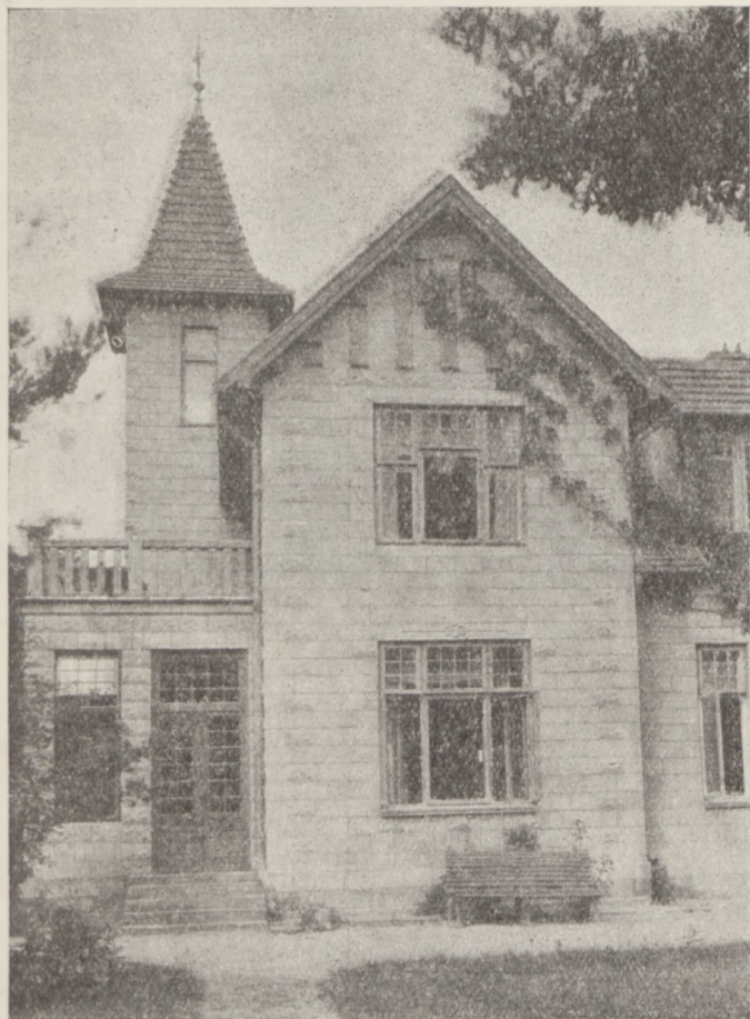
Willa (pensjonat) p. Skrobańskiej w Milanówku pod Warszawą, zbudowana z pustaków w r. 1911.
