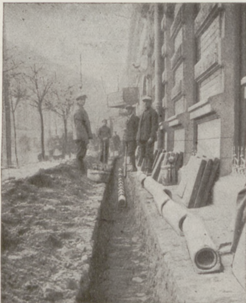
Rys 9. Układanie rur 1-otworowych na Placu Wolności we Włocławku.
