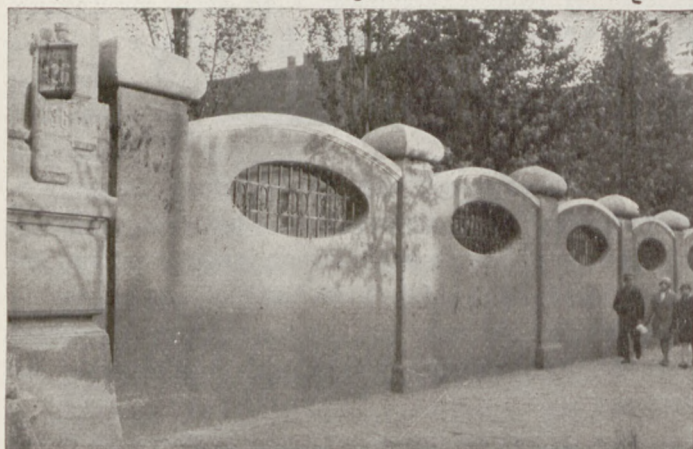
Ogrodzenie betonowe posesji fabrycznej przy ul. Piotrkowskiej Nr. 138/140 w Łodzi.
