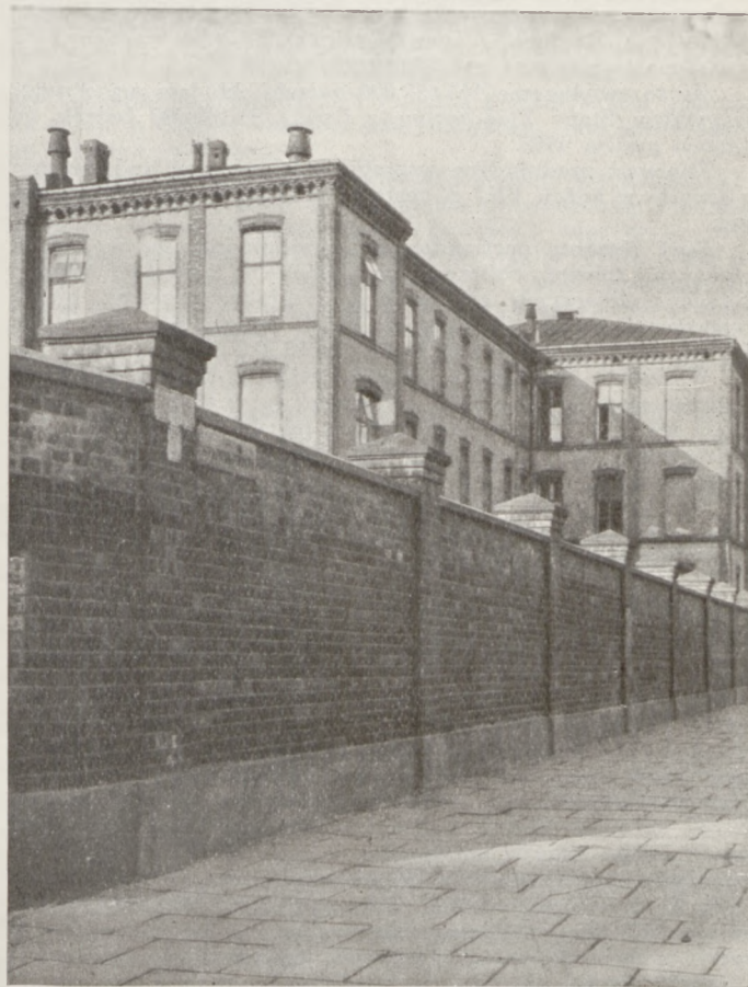
Ogrodzenie szpitala Dz. Jezus przy ulicy Starynkiewicza w Warszawie z cegły zwykłej posiada betonowe płyty nadmurowe doskonale chroniące cegłę od zniszczenia.
