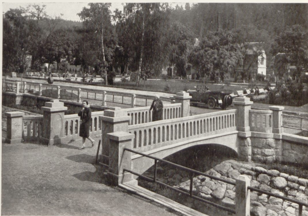
KŁADKA ŻELBETOWA NAD POTOKIEM „KRYNICZANKA” W KRYNICY.
