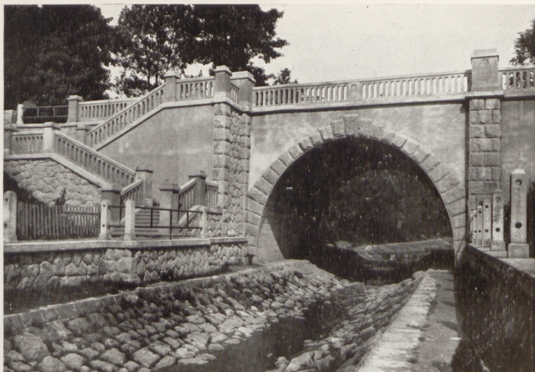
MOST BETONOWY NAD „KRYNICZANKĄ”, NA PAŃSTWOWEJ DRODZE KOŁOWEJ, PROWADZĄCEJ Z MUSZYNY DO KRZYŻÓWKI W KRYNICY.
