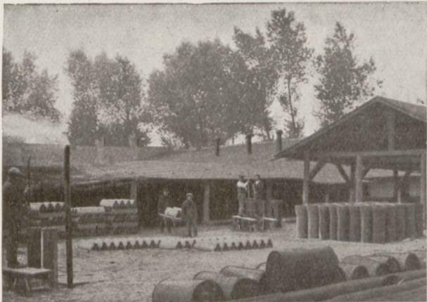
Rys 8. Ogólny widok fabrykacji rur cementowych.
