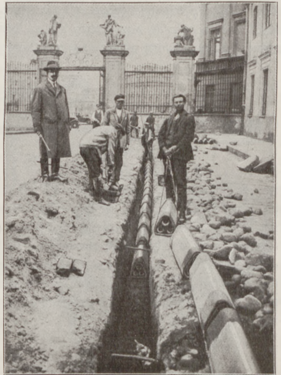
Rys 10. Układanie rur 3-otworowych na Placu Saskim w Warszawie (Podwórko Telegrafu)
