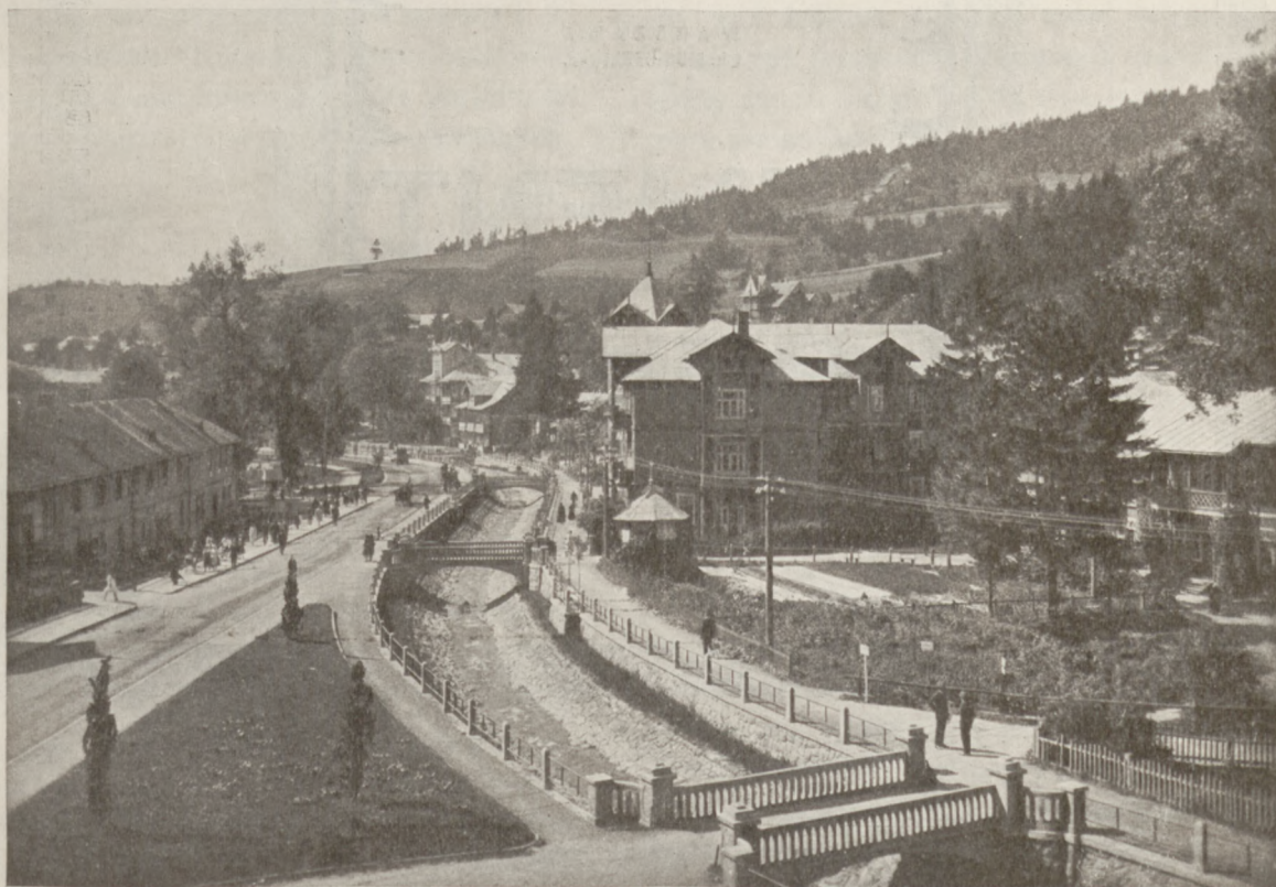
Widok na bulwary i kładki żelbetowe na potoku „Kryniczanka”, w Krynicy.
