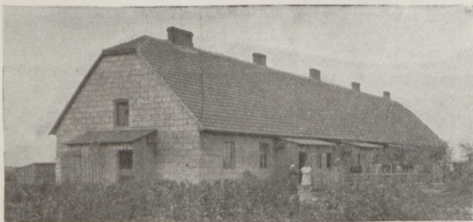
Barak dla bezdomnych pobudowany z pustaków betonowych, przykryty dachówką cementową. Pobudował go Magistrat m. Sochaczewa w odległości 1 km. od tegoż miasta przy szosie Sochaczew-Blonie. Barak posiada 20 mieszkań dla pojedynczych rodzin.
