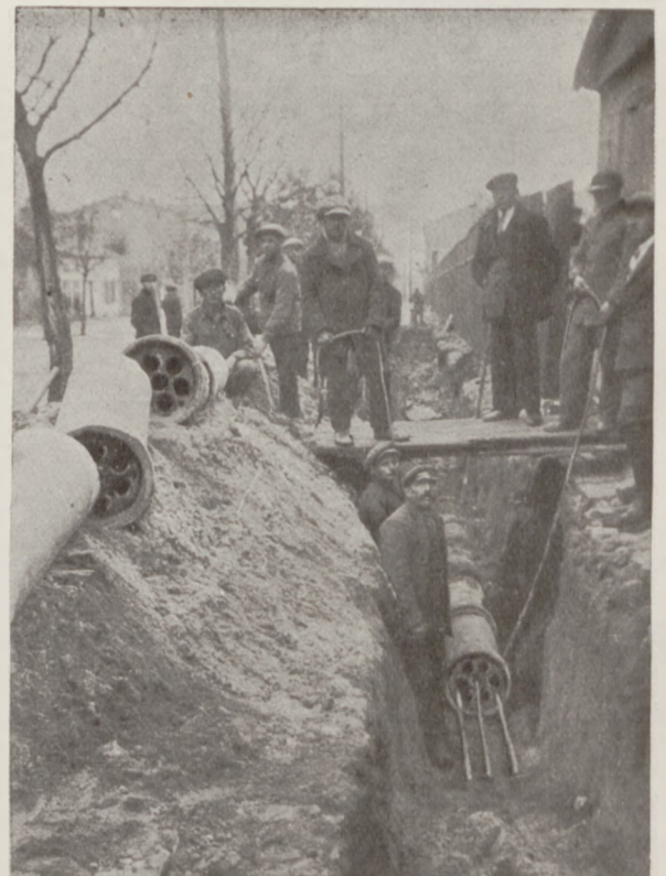
Rys 11. Układanie rur 7-otworowych na ul. Warszawskiej we Włocławku.
