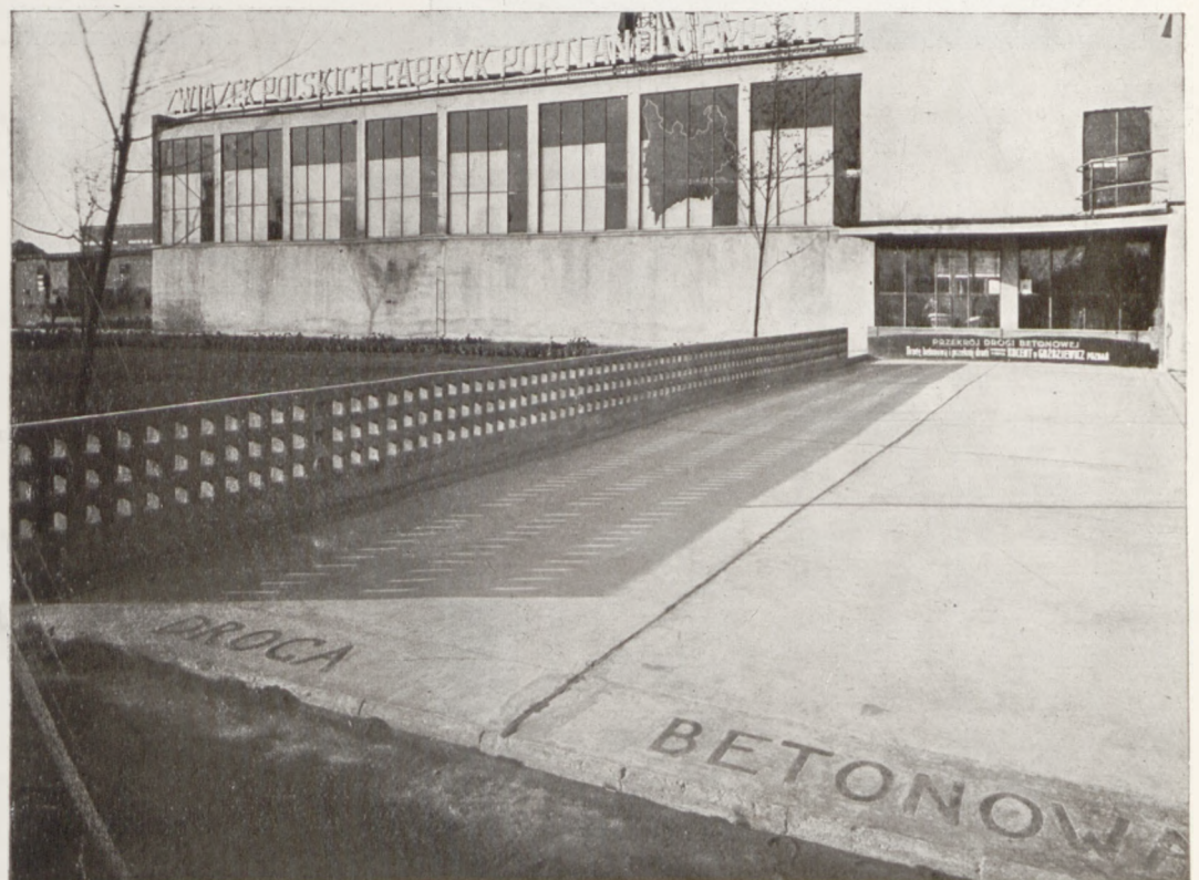
ODCINEK DROGI BETONOWEJ, JAKO WZÓR IDEALNEJ NAWIERZCHNI.
