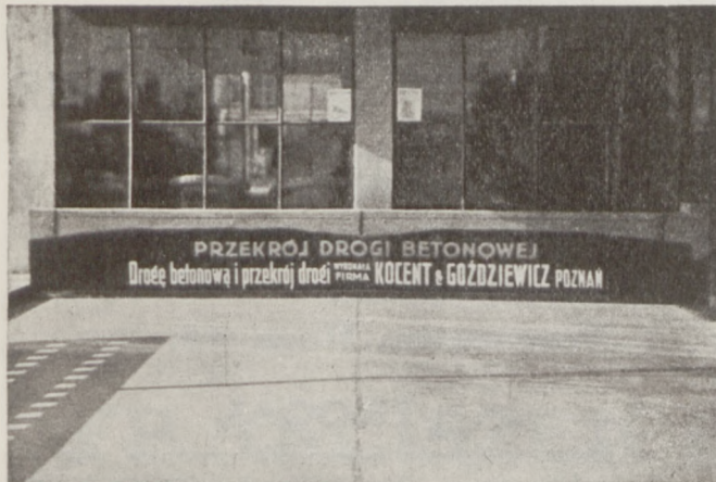
Firma nasza wykonała odcinek drogi betonowej, położony przy pawilonie Spółki Centrocement na P. W. K. w Poznaniu.
