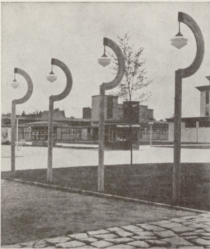
Oryginalne słupy betonowe z zakończeniami sierpowymi do oświetlania terenu przemysłu cementowego.
