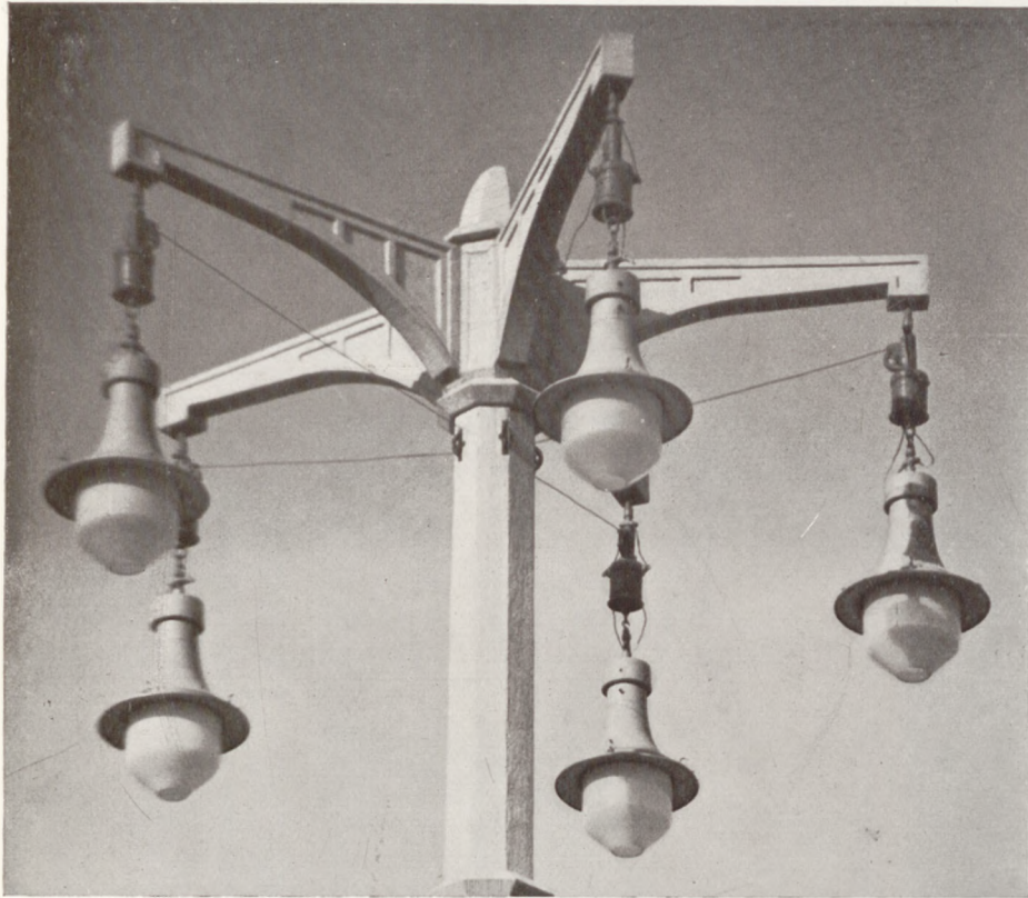
PIĘCIORAMIENNY KANDELABR SŁUPA ŻELBETOWEGO.
