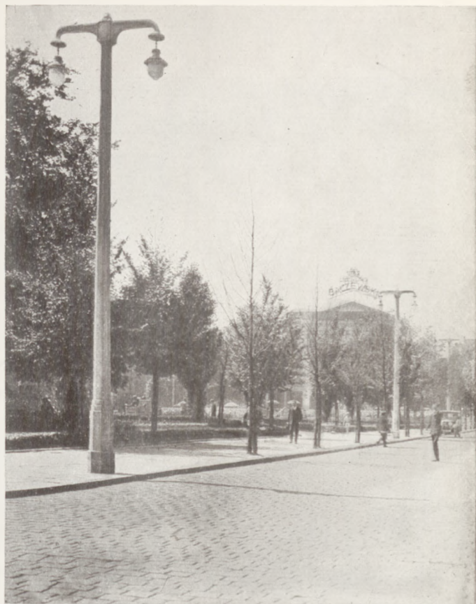
ŻELBETOWY SŁUP DWURAMIENNY NA PLACU WOLNOŚCI W POZNANIU.
