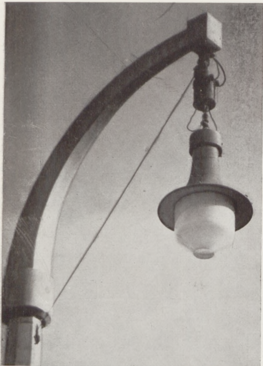
ZAKOŃCZENIE JEDNORAMIENNEGO SŁUPA ŻELBETOWEGO.
