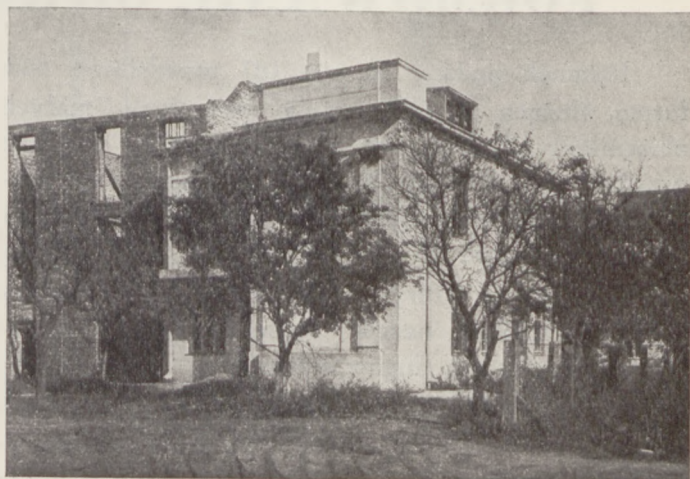
Fot. 13. Dom z pustaków po wykończeniu, własność p. S. Bulanowa, na Saskiej Kępie w Warszawie.
