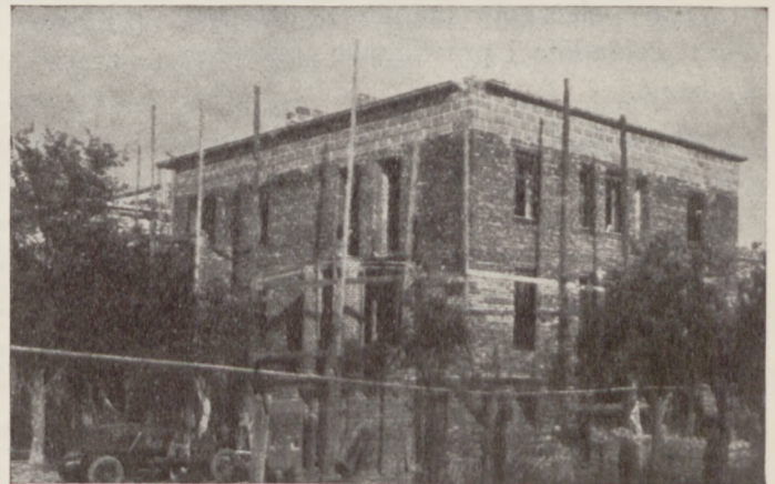
Fot. 10. W jednym z domów ceglanych tej spółdzielni nadbudowano pustakami ściany zewnętrzne, otaczające płaski dach tarasowy. Atyk ten zakończony jest gzymsowemi płytami betonowemi, zbrojonemi, które wykonane zostały w specjalnej formie drewnianej. Brakujące narożniki betonowe były na miejscu po ułożeniu sąsiednich płyt wykończone.
