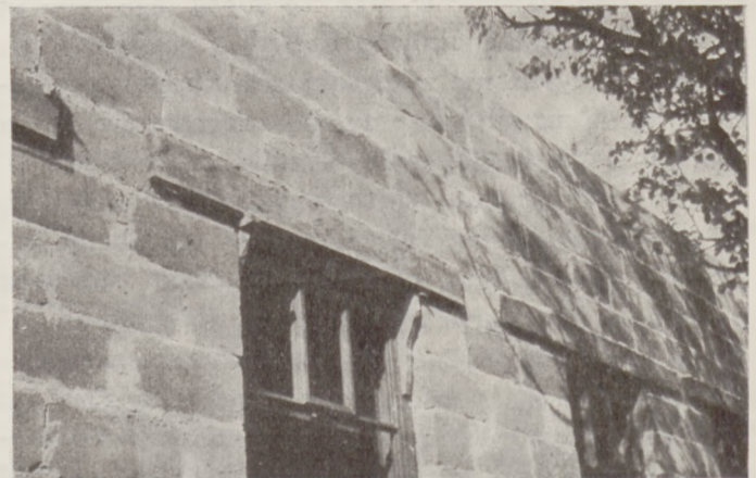
Fot. 7. Formy drewniane, służące do formowania belek nadotworowych.
