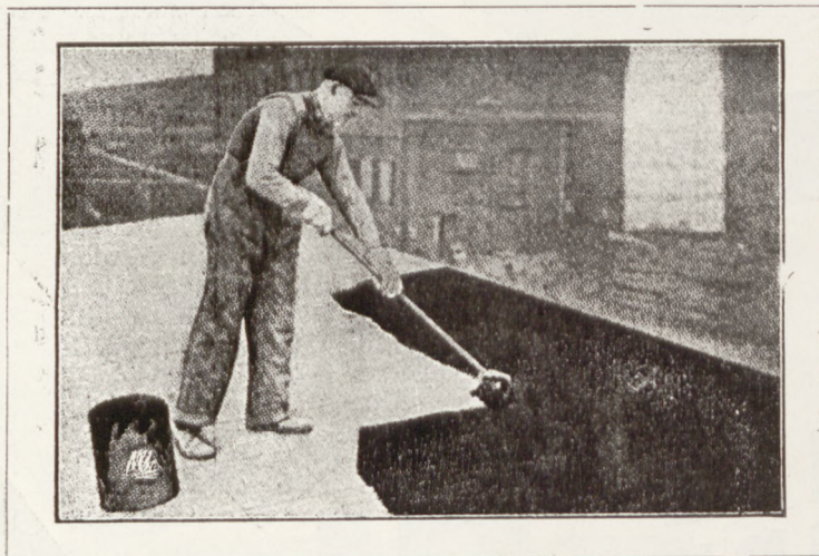
Trocal półgęsty na dachu
