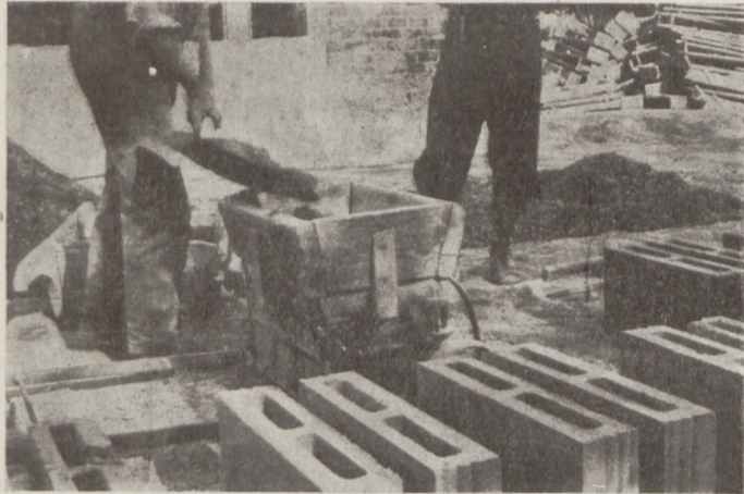
Fot. 3. Korytka drewniane, nakładane na formę żelazną, oszczędza i ułatwia nasypanie masy betonowej przy wyrobie pustaków. Na froncie fotografii widzimy gotowe półówki pustaków.
