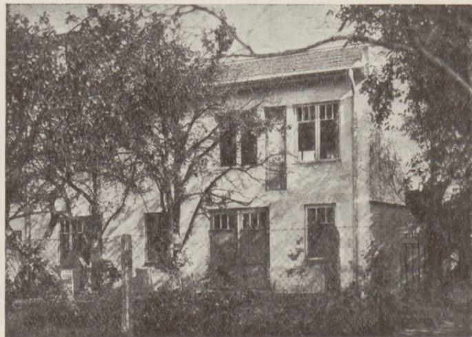
Fot. 14. Dom z pustaków po wykończeniu, własność p. S. Obolońskiego, na Saskiej Kępie w Warszawie.
