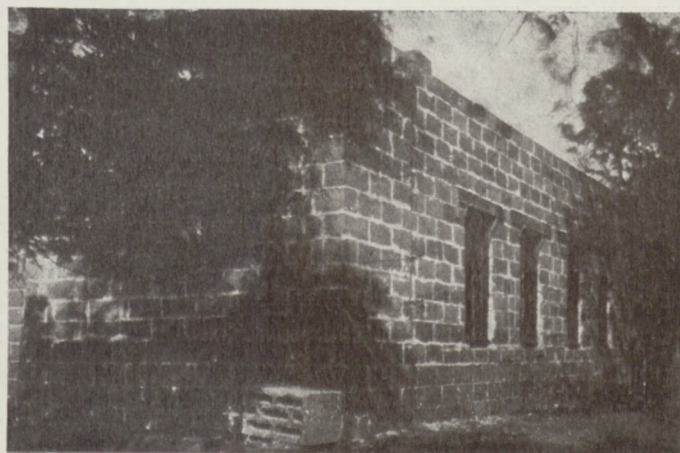
Fot. 1. Budowa domu z pustaków na Saskiej Kępie w Warszawie.
