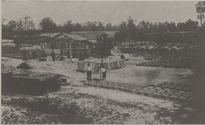
Widok ogólny betoniarni sejmiku włozimierskiego w Sierakówce.
