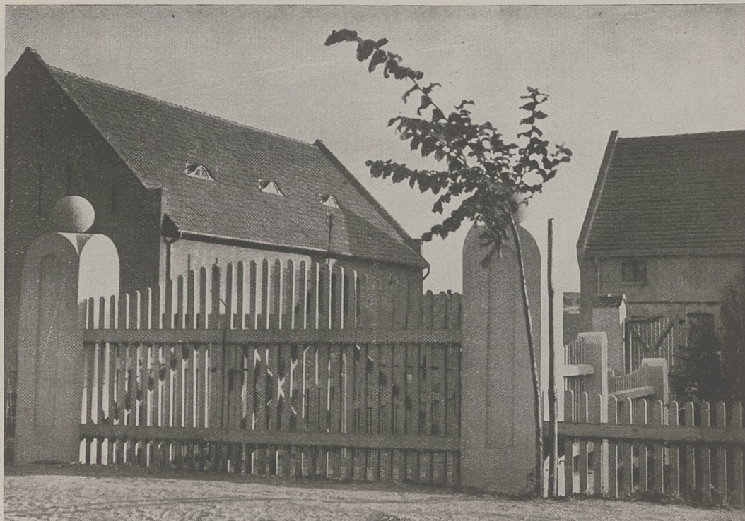
SŁUPY BETONOWE PODTRZY- MUJĄCE BRAMĘ I SZTACHE- TY, OTACZAJĄCE JEDNO Z GOSPODARSTW WIEJSKICH W OKOLICACH GDYNI.
