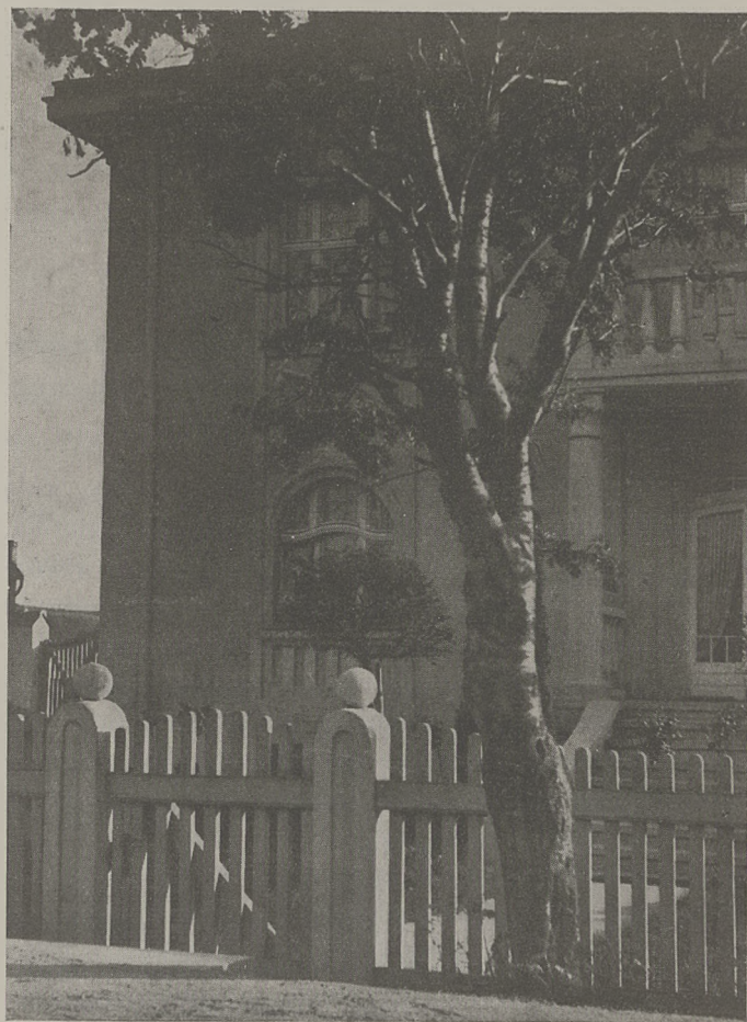
Słupki betonowe, zakończone kulami, podtrzymujące sztachety drewniane, przy willi „Szczęść Boże” w Gdyni. Przy budowie tej pięknej willi beton znalazł szerokie zastosowanie w postaci: schodów, słupów podpierających balkony, tralek ze sztucznego kamienia itd.
