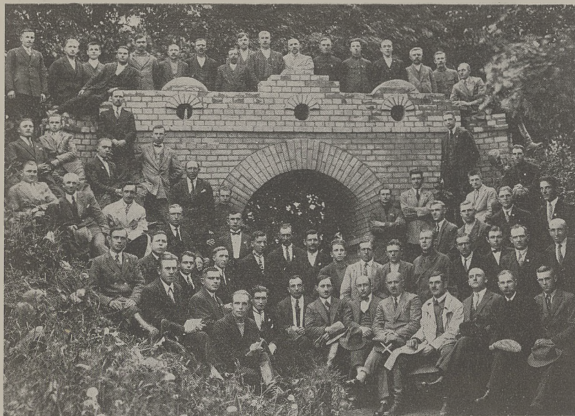
Sluchacze Kursu betoniarstwa w Siedlcach. Zdjęcie w parku miejskim na tle t. zw. mostu ks. Ogińskiej, zbudowanego z cegły cementowo-piaskowej. Po między słuchaczami widzimy siedzącego Prezydenta m. Siedlec p. Ignacego Kubeckiego (X).
