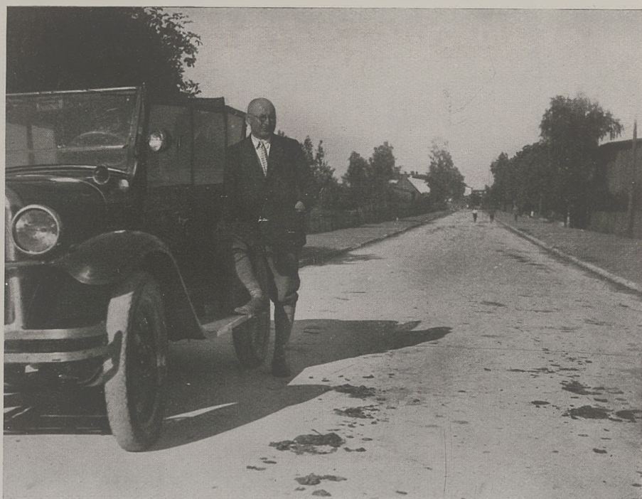
NAWIERZCHNIA BETONOWA UŁOŻONA NA ZNISZCZONEJ POWŁOCE SZOSOWEJ NA DRO- DZIE CZERSK — LEGBĄD. DROGA BETONOWA W GRANICACH MIASTA CZERSKA. PRZY SAMOCHODZIE STOI INICJATOR BUDOWY DRÓG BETONOWYCH W POW. CHOJNICKIM INŻ. HERMAN KOCH.
