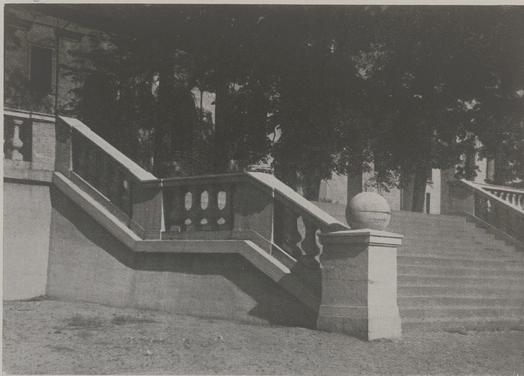
SCHODY, ŚCIANY OPOROWE, TRALKI I PORECZE PRZED WEJŚCIEM DO TUMY W GNIEŹNIE, WYKONANE ZE SZTUCZNEGO KAMIENIA.
