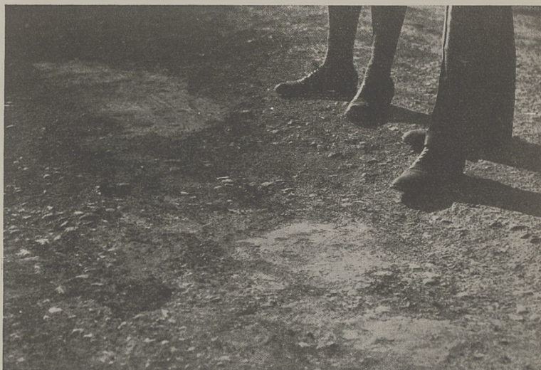
Naprawianie zniszczonej nawierzchni szabrowej, na szosie tranzytowej Czersk—Starogard, przez wypełnianie większych zagłębień powierzchni mieszanką cementu z piaskiem w stosunku 1:3. Białe odcinające się plamy na nawierzchni szosowej oznaczają owe wypełnienia.
