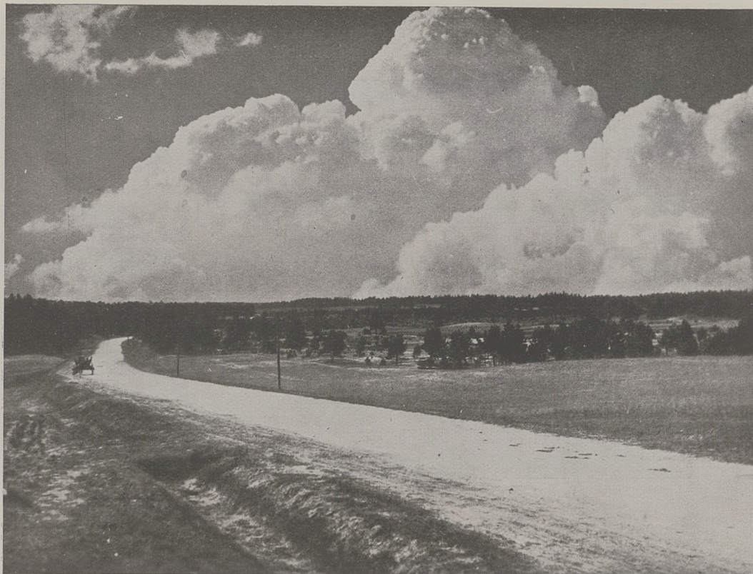
DROGA BETONOWA SWORNE- GACIE — CHOCIŃSKI MŁYN. DŁUGOŚĆ NAWIERZCHNI BE- TONOWEJ NA TYM ODCINKU WYNOŚI DOTYCHCZAS 2.4 KI- LOMETRA.
