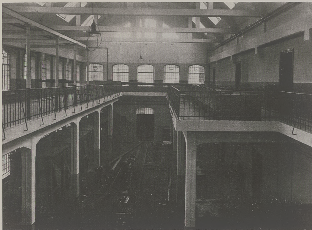
PAŃSTWOWA SZKOŁA WŁÓ- KIENNICZA W ŁODZI. PAWI- LON MECHANICZNY. WNE- TRZE SALI OBRABIAREK.
