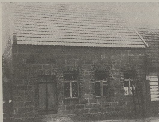
Budynek prywatny w Brasławiu, wybudowany z pustaków i pokryty dachówką cementową.
