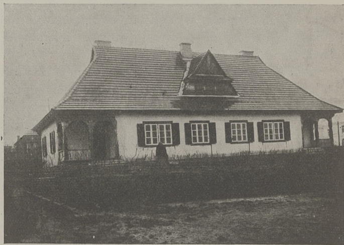
Budynek rządowy w Brasławiu pokryty dachówką cementową z betoniarni sejmikowej.
