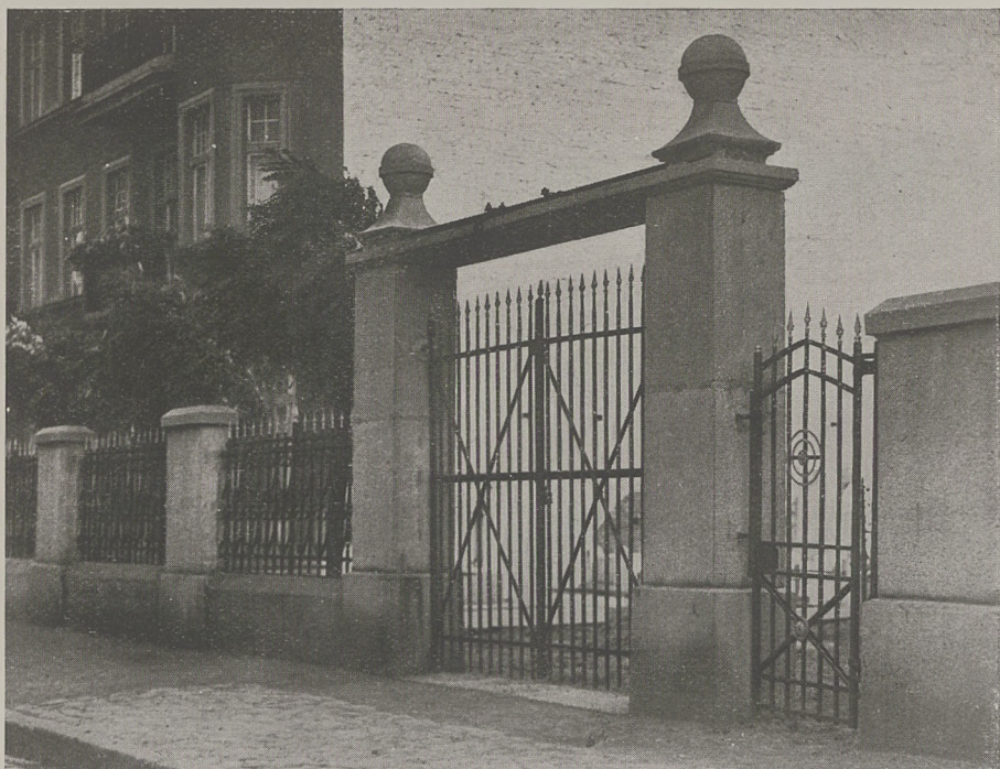
SŁUPY W BRAMIE I PARKANIE, WYKONA- NE ZE SZTUCZNEGO KAMIENIA, PRZY UL. NARUTOWICZA W GRUDZIĄDZU.
