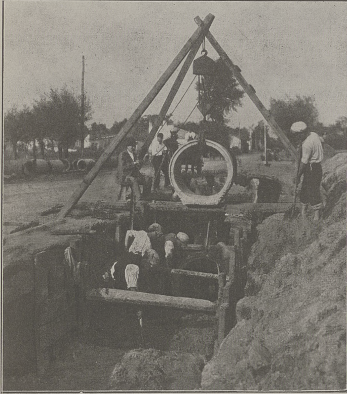
Zapuszczanie rur betonowych przy budowie kolektorów miejskich w Ciechocinku.
