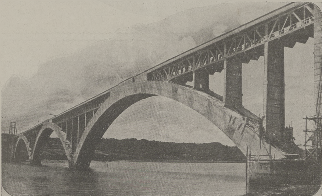
Most żelbetowy na rz. Elorn w Plougastel (we Francji) z trzema największemi na świecie łukami żelbetowemi, po 186 metrów rozpiętości, otwarty dla ruchu w dniu 9 października 1930 r.
