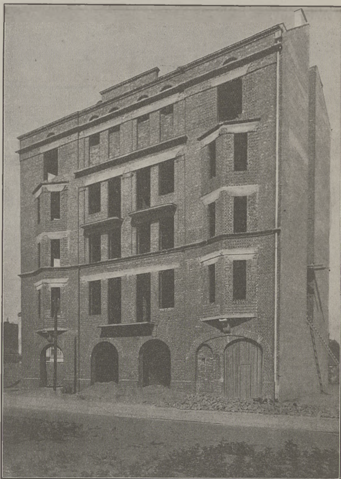
Jeden z budowanych domów mieszkalnych w Gdyni, w którym szeroko stosowany jest beton w postaci belek nad otworami, płyt balkonowych, gzymsów wystających i t. p.
