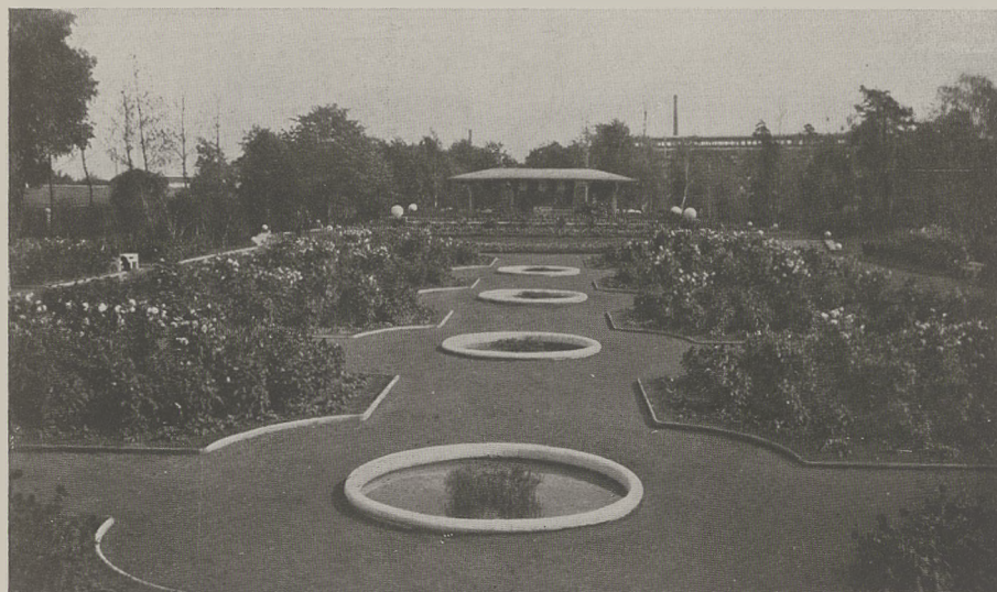
ZBIORNIKI BETONOWE DLA ROŚLIN WODNYCH W PARKU KOŚCIUSZKI W KATOWICACH.
