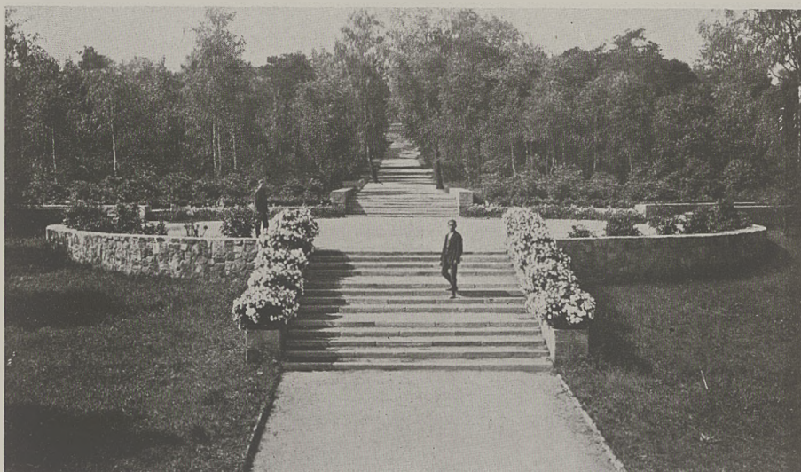
SCHODY Z OBRZEŻY BETONOWYCH W PARKU KOŚCIUSZKI W KATO- WICACH.
