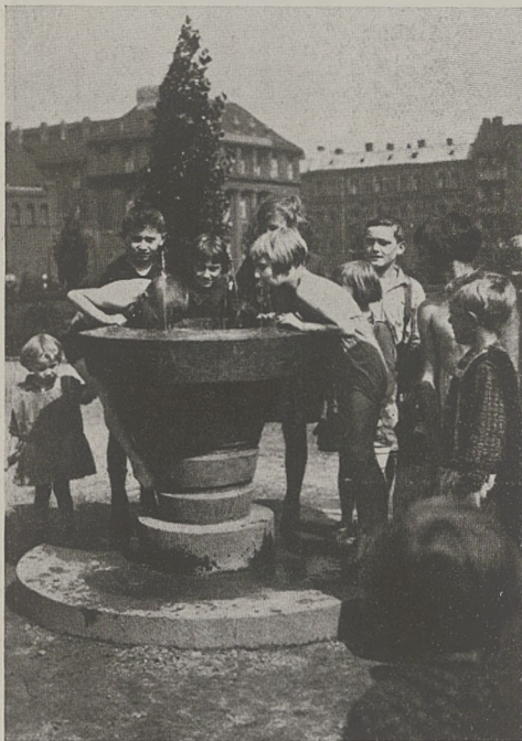
PIJALNIA BETONOWA NA PLACU ANDRZEJA W KATOWICACH.
