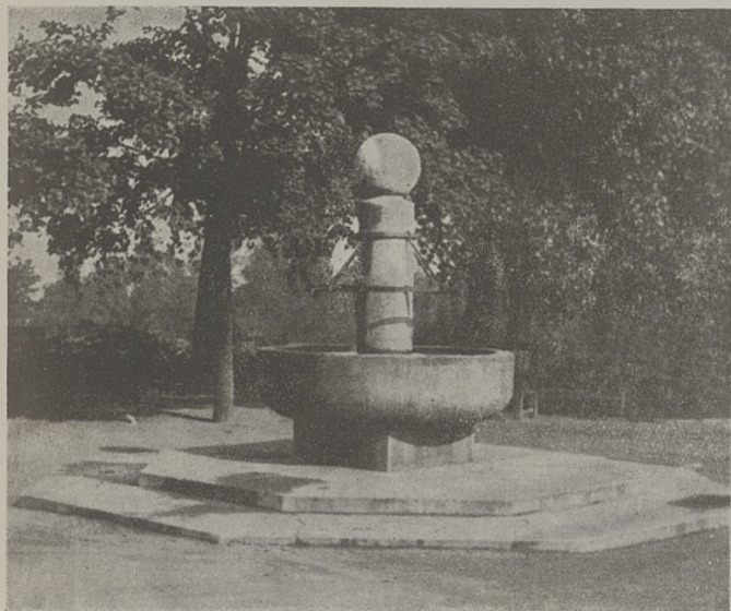
Studnia wodociągowa ze sztucznego kamienia w parku Kościuszki w Katowicach.
