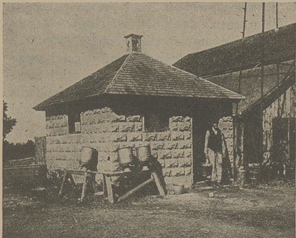
Fig. 7. Widok chłodni z pustaków betonowych.
