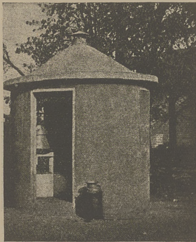
Fig. 8. Widok chłodni okrągłej z betonu zbrojonego.
