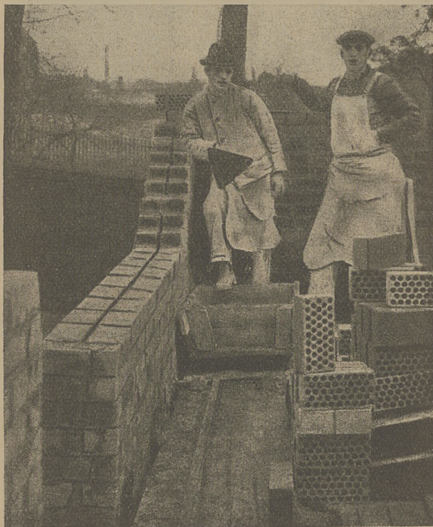
Fig. 2. Murowanie ściany zewnętrznej.
