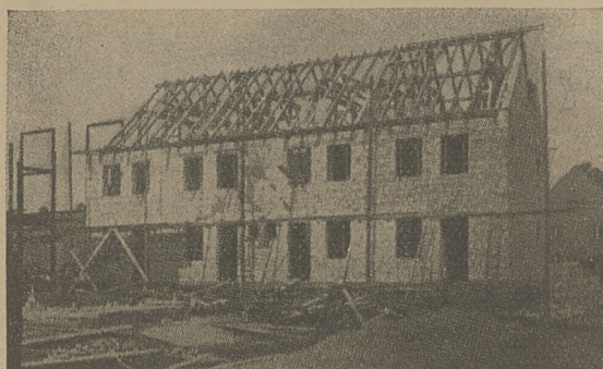
Fig. 3. Budowa domu z bloków dimabetonowych.
