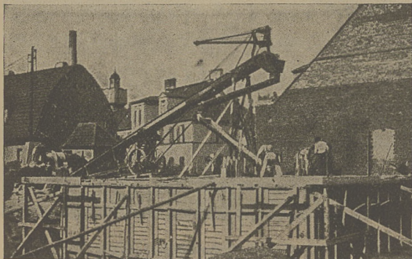
Fig. 2. Rozlewanie dimabetonu do znormalizowanych deskowań.
