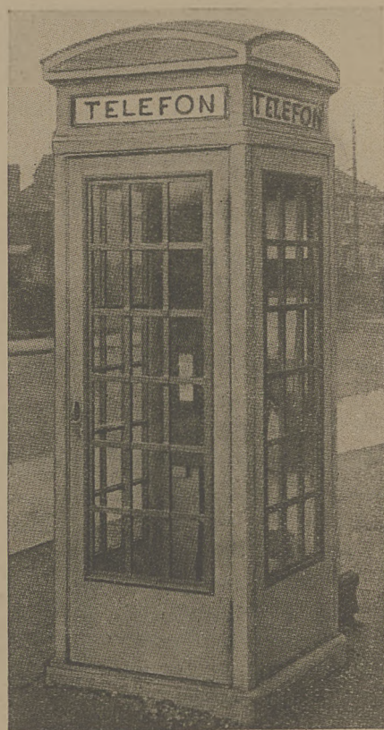
Fig. 2. Telefoniczna budka z betonu.
