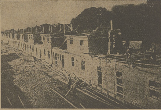
Fig. 1. Budowa osiedla robotniczego z żużlobetonu w Niemczech.
