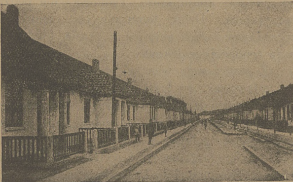
Fig. 2. Widok uliczki gotowego osiedla z żużlobetonu.
