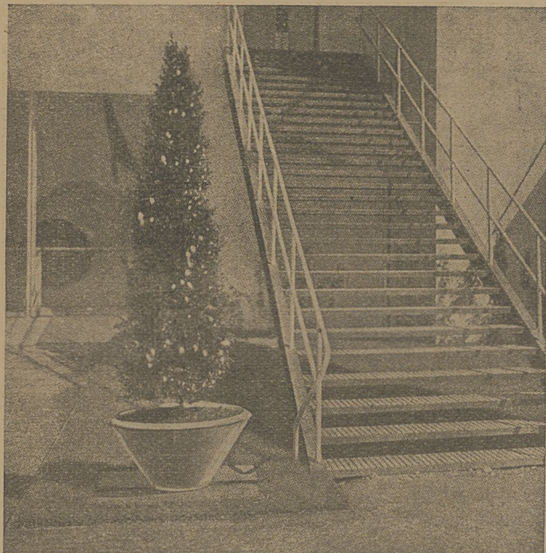
Fig. 3. Piękną ozdobą trawników są betonowe wazony z krzewami.
