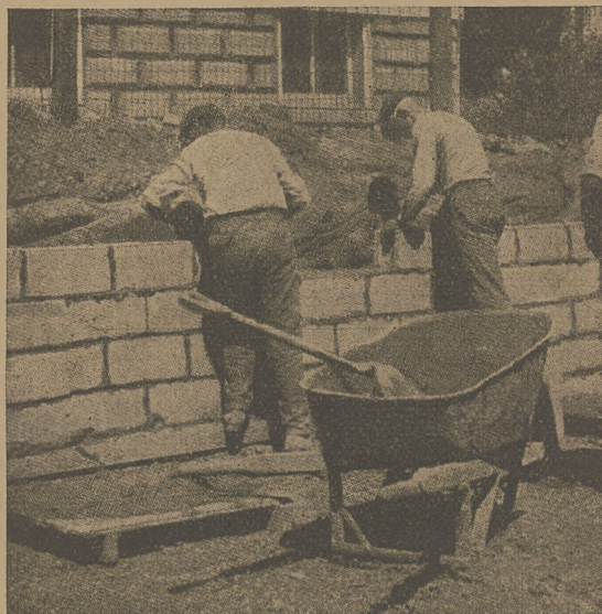
Fig. 4. Budowa ściany z bloków żuźlobetonowych.
