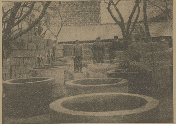
Kręgi studienne wykonane przez słuchaczy kursu na tle wzorowej betoniarni; wдали widać ściany budynku z pustaków.
