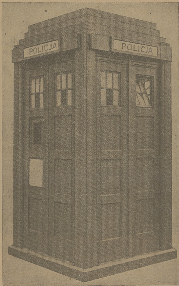
Fig. 3. Budka betonowa dla policji.
