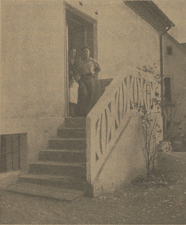
Fig. 1. Widok ogólny poręczy betonowej.
