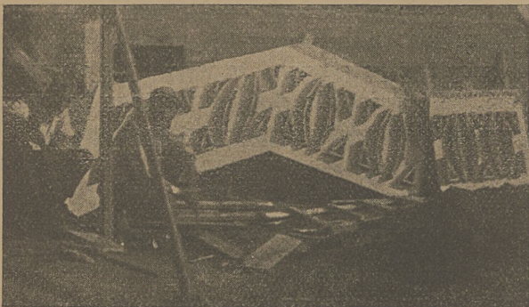
Fig. 2. Wykonanie formy drewnianej do poręczy.
