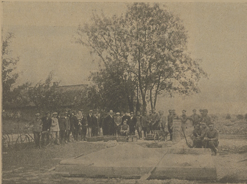
Grupa członków Straży Pożarnej przy budowie.
