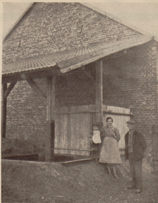
Fig. 2. Typowy jednokomórkowy dół kiszonkowy z betonu p. Leona Smolki z Belsznicy, pow. Rybnik, woj. Śląskie.
