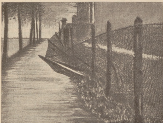
Fig. 1. Widok ogrodzenia z siatki drucianej po zgniciu słupów drewnianych.
