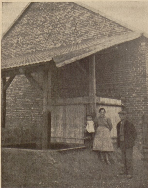
Fig. 4. Czterokomorowy dół kiszonkowy z betonu w gospodarstwie p. Józefa Pietruchy w Łągiwnikach Wielkich, powiat Lubliniec, wojew. śląskie. W głębi dwie komory nabite, z przodu komora jeszcze wolna, obok niej komora przygotowana do napełniania, z nasadką drewnianą.
