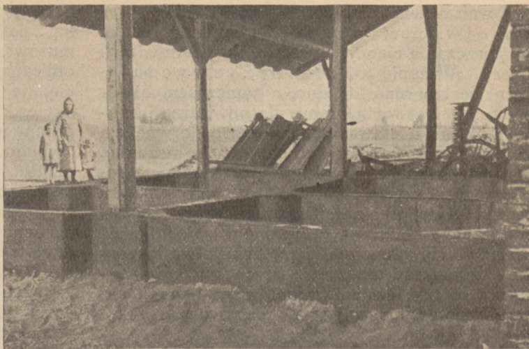
Fig. 5. Czterokomorowy dół kiszonkowy z betonu w gospodarstwie p. Izidora Kołodziejczyka w Pawonkowie, pow. Lubliniec, woj. śląskie. Powierzchnia jednej komory 4,26 m 2 , głębokość 2,00 m, z tego nad terenem 60 cm.
