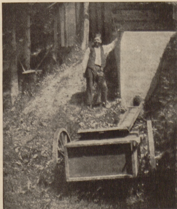
Fig. 2. Wybieranie gnojówki ze zbiornika betonowego.
