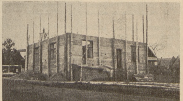
Fig. 3. Domek dla letników w Zarytem na Podhalu. Na fundamencie z betonu żwirowego, wybetonowano z żużłobetonu ściany, w deskowaniu podciąganiem w górę w miarę postępu pracy.
