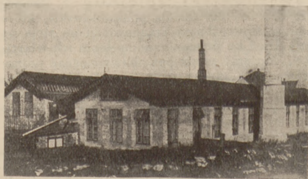
Fig. 5. Żużlobetonowy budynek malarni w fabryce porcelany w Cmielowie.
