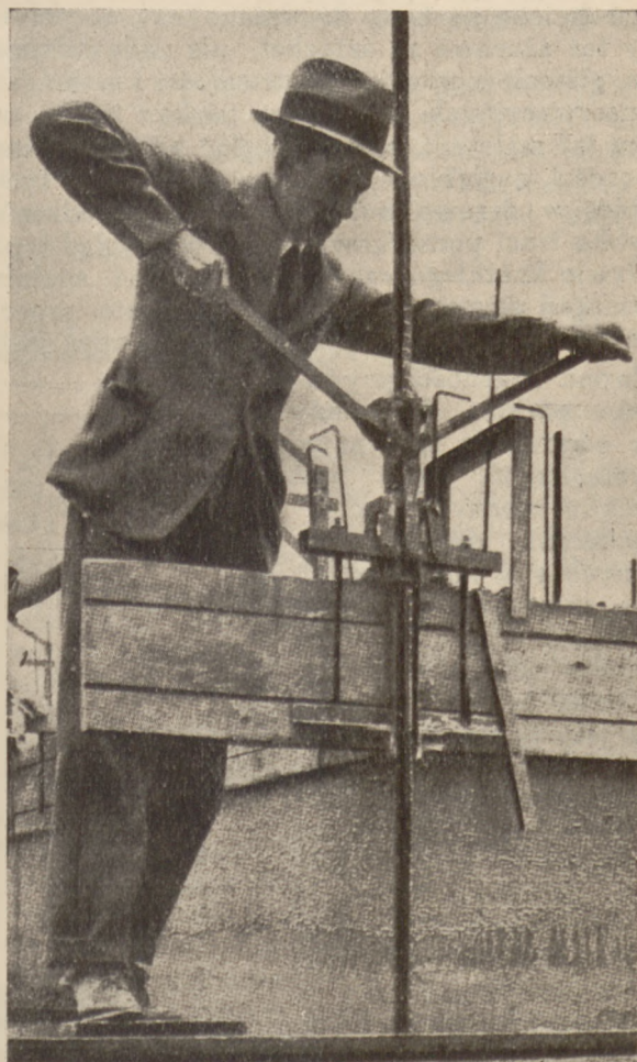
Fig. 2. Dźwignia do podnoszenia deskowania.
