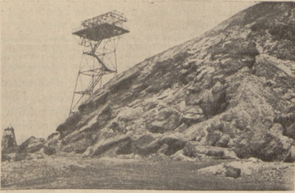
Fig. 1. Zwał żużła kotłowego przy Zakładach Elektro w Łaziskach Górnych na Górnym Śląsku.
