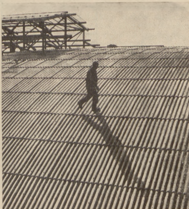
Fig. 4. Dach hali fabrycznej, kryty eternitem falistym.
