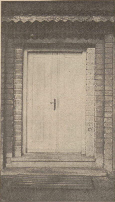
Rys. 4. Drzwi wejściowe do jednego z domów Zakładu obramowane cegłą cementową.
