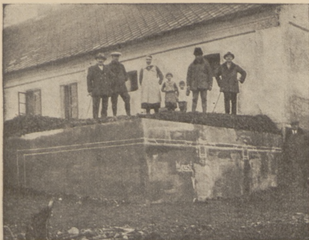
Rys. 4. Wzorowa gnojownia podgórska w gospodarstwie p. Antoniego Hellera w Brennej, pow. Cieszyn. Na ścianach gnojowni nakreślono kredą zarys konstrukcji żelbetowej, nakrywającej zbiornik na gnojownię.
