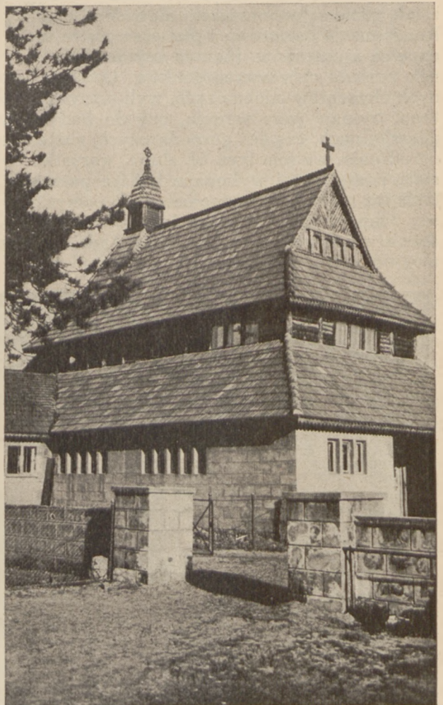
Rys. 1. Widok kaplicy od strony południowo-wschodniej; na przodzie część ogrodzenia cmentarnego z pustaków.
