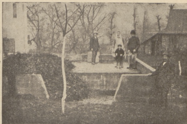
Rys. 5. Gnojownia podgórska z fig. 4, widziana od strony wjazdu. W bieżącym roku p. Józef Heller wbuduje próg betonowy, którego brak powodował przedostawanie się wody ściekowej do wnętrza gnojowni.
