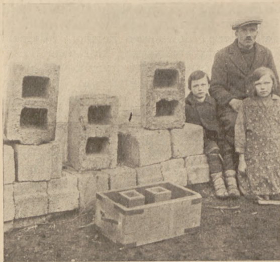
Rys. 2. Pustaki żużlobetonowe, użyte do budowy budynku z rys. 1. Otwory są z jednej strony zasklepiene. Na pierwszym planie forma drewniana do wyrobu pustaków, obita od wewnątrz blachą.
