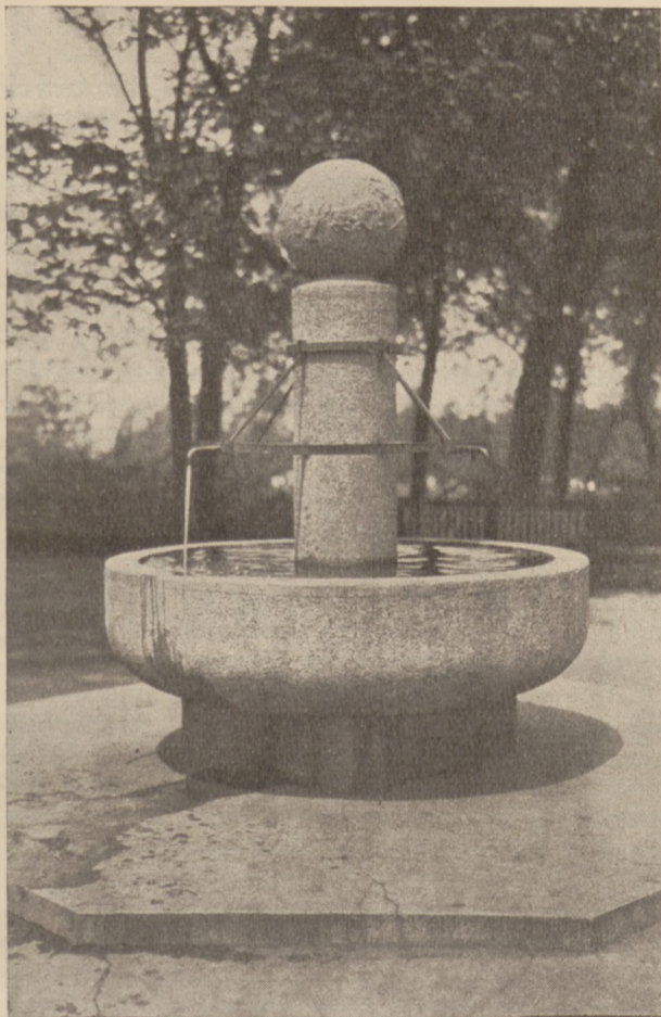
Rys. 10. Studnia ze sztucznego kamienia, ozdobiona u góry kulą betonową.
