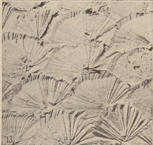
Rys. 11. Wyprawa zacierana kielnią w łuki, rys. 12 — zacierana kielnią w sierpy, rys. 13 — zacierana kielnią wachlarzowato.
