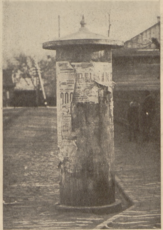
Słup ogłoszeniowy, wykonany z kręgów studziennych.
