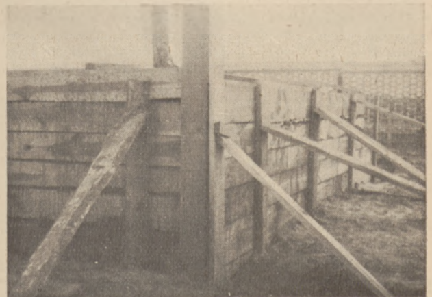
Rys. 2. Deskowanie muru fundamentu nad ziemią. Fot. „Contax”.
