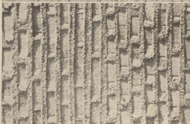
Rys. 27. Wyprawa dociskana kielnią zaokrągloną pionowo.
