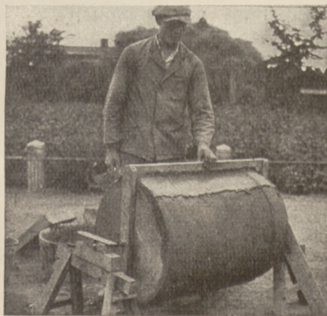
Rys. 6. Wykonanie beczki żelbetowej w sposób obrotowy.
