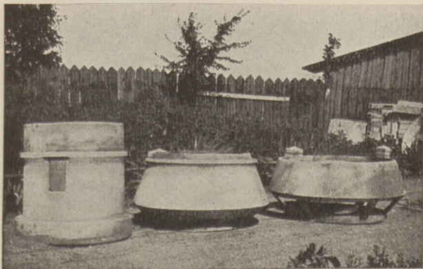
Rys. 4. Nasada kominowa (deflektor) dla parowozowni przed zmontowaniem.
