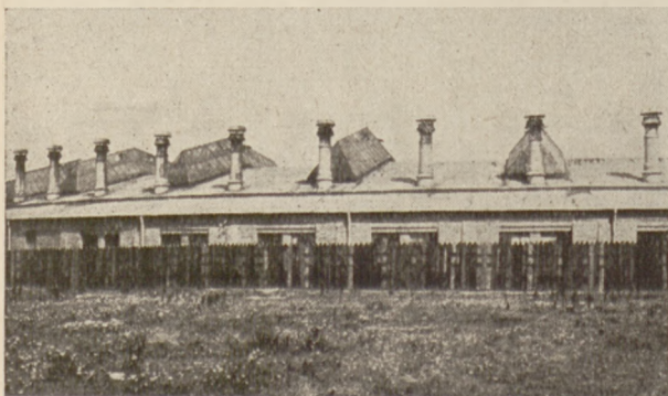
Rys. 1. Ogólny widok parowozowni w Kutnie z nasadami kominowemi z betonu na dachu żelbetowym.
