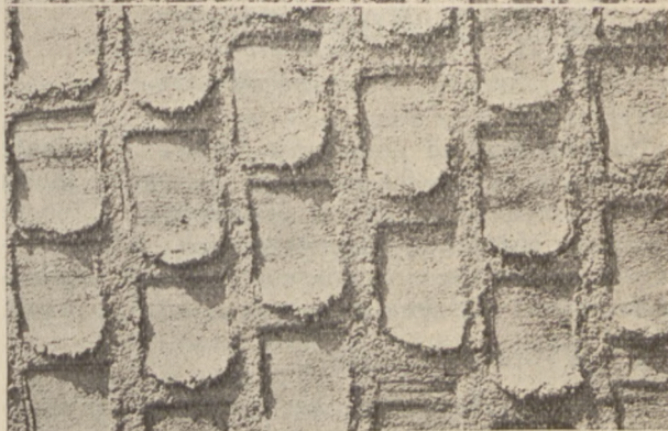
Rys. 29. Wyprawa dociskana połową kielni pionowo.
