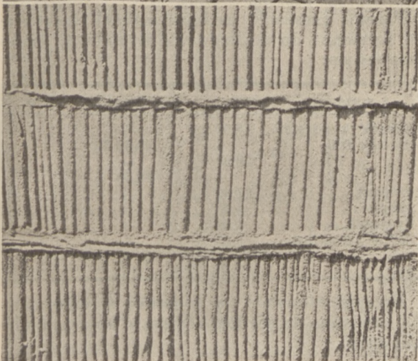
Rys. 27. Wyprawa dociskana kielnią zaokrągloną pionowo.
