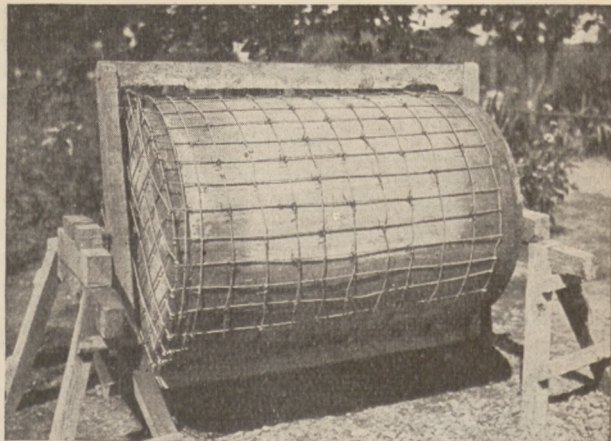
Rys. 5. Zbrojenie z siatki drucianej do wyrobu beczek.
