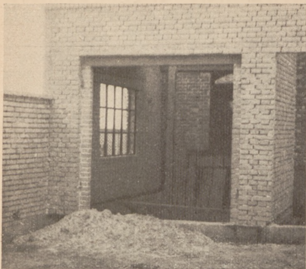
Widok garażu z cegły cementowej w stanie surowym.
