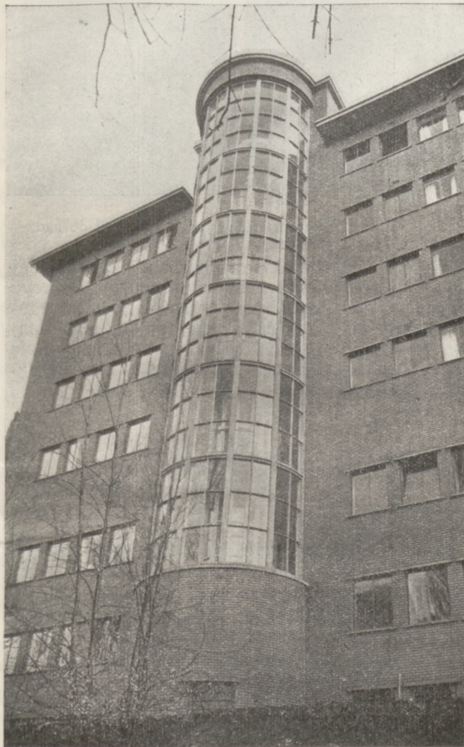
Fig. 3. Żelbetowe okna klatki schodowej.
