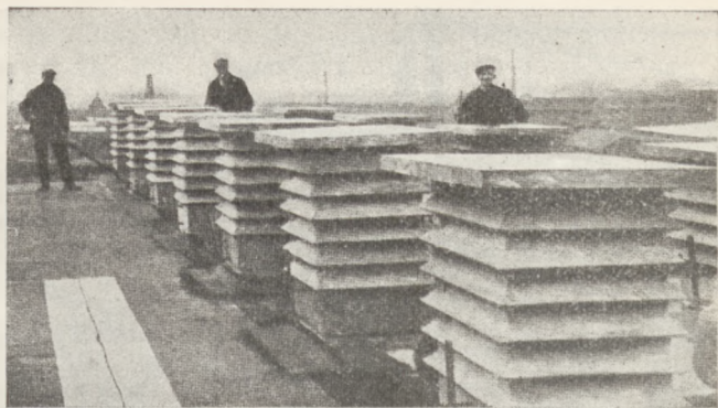
Fig. 4. Żelbetowe wentylatory dachowe.
