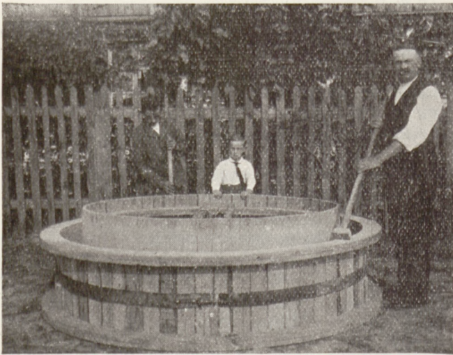
Fig. 7. Budowa dołu kisonkowego w formie drewnianej w jednym z gospodarstw wielkopolskich.
