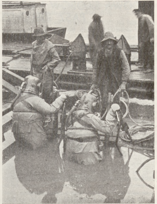
Fig. 6. Skomplikowane prace podwodne wykonuje się łatwo przy pomocy narzędzi pneumatycznych.
