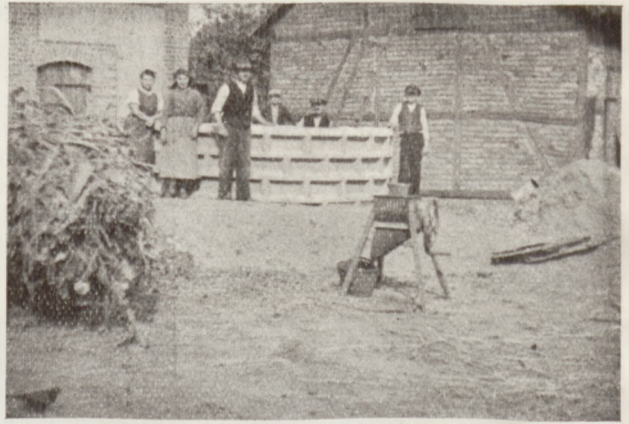
Fig. 8. Budowa dołu kisonkowego z bloków betonowych w jednym z gospodarstw wielkopolskich.
