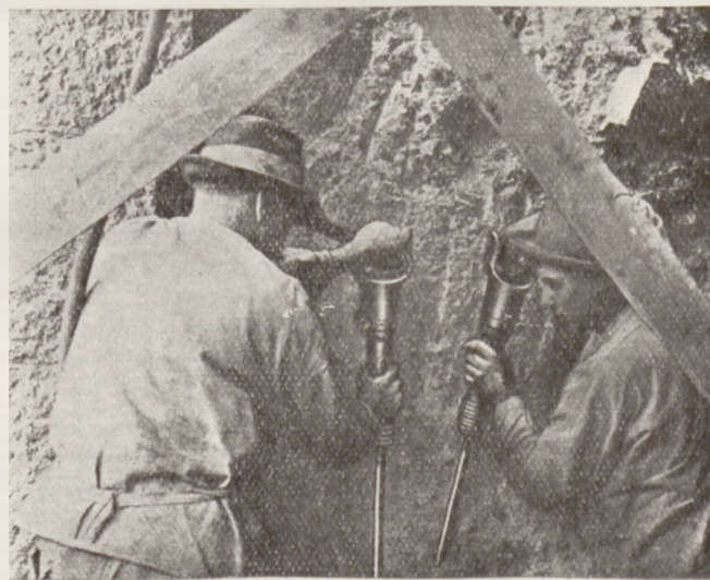
Fig. 3. Obrabianie i wyrównywanie powierzchni betonu przy pomocy młotków pneumatycznych.
