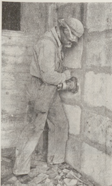
Fig. 5. Szlifowanie murów szlifierką pneumatyczną.
