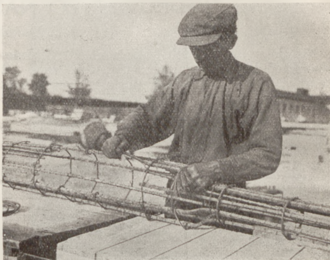
Fig. 5. Montaż uzbrojenia ze stali grzebieniowej do masztu oświetleniowego dla Elektrowni Warszawskiej.
