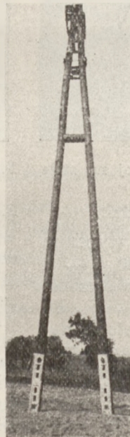
Fig. 2. Drewniany słup linii wysokiego napięcia osadzony na pasierbach (cokołach) żelbetonowych.
