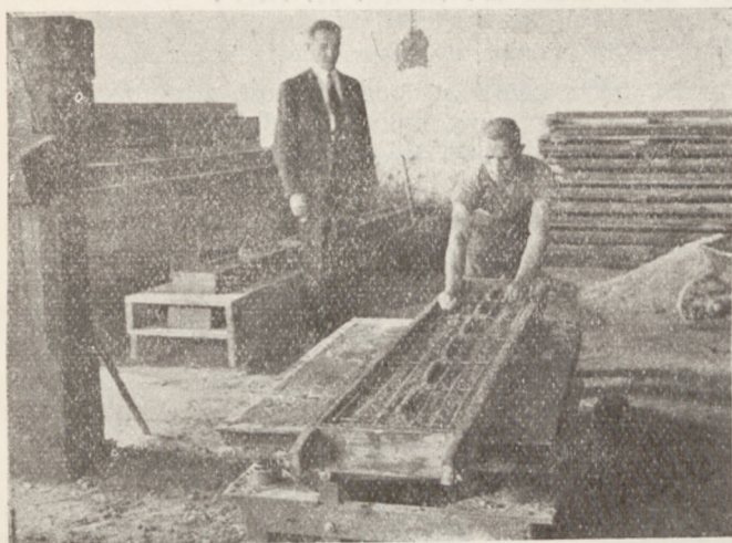
Fig. 4. Fabrykacja żelbetowej dyliny mostowej na stole wibracyjnym.
