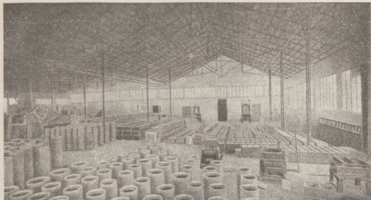
Fig. 1. Betoniarnia doświadczalna jednej z francuskich maszyn betoniarskich. W głębi widoczne prasy wstrząsowe do produkcji różnych wyrobów, — na lewo maszyna do wyrobu rur systemem podłużnego prasowania, — na pierwszym planie maszyna do wyrobu bloków żużlobetonowych.
