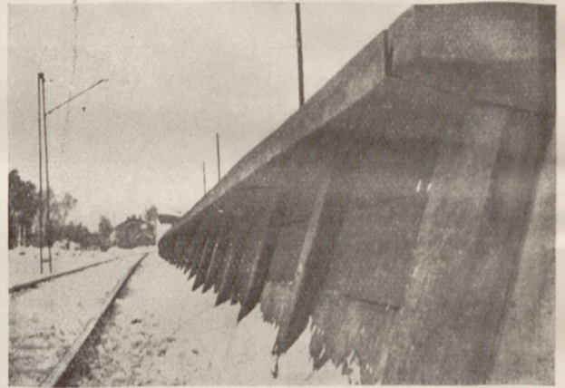
Wysoki peron kolejowy składany z gotowych elementów żelbetowych.
