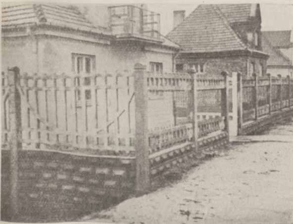
Fig. 1. Płot żelbetowy ażurowy wg szkiców 25 i 26.
