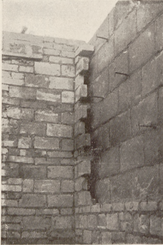
Budowa ściany z pustaków grub. 25 cm ocieplonej ścianką ceglana z \frac{1}{4} cegły.
