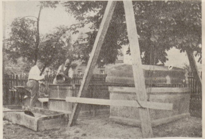
Wykonywanie żelbetowej skrzyni trumiennej.
