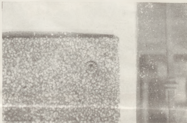
Fig. 2. Narożnik płyty z fig. 1 w zbliżeniu. Widoczne umocowanie płyty ozdobnymi sztyldzikami osadzonymi na wkrętkach wchodzących w kołki umocowane w murze.
