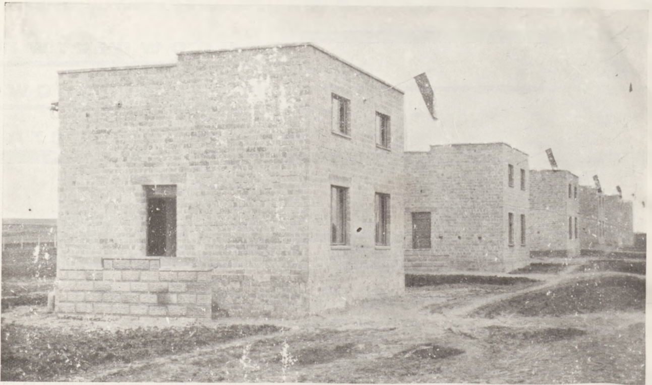
Fig. 1. Kolonia domków robotniczych jednorodzinnych w Gniewie na Pomorzu. Plan i wymiary domków podano na rys. 2. — Domki wzniesiono całkowicie z pustaków betonowych „Ideal”.
