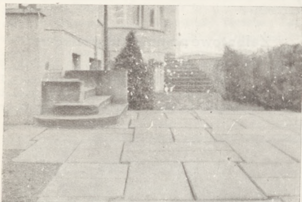
Fig. 1. Nowy sposób układania płyt betonowych chodnikowych prostokątnych.
