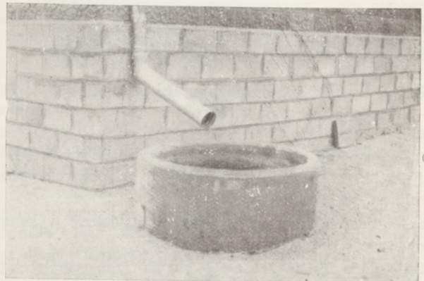
Fig. 5. Zapobiegliwa gospodyni ustawiła pod rynną krąg betonowy z zabetonowanym dnem w celu gromadzenia deszczówki dla celów gospodarczych.
