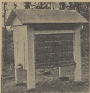
Ul z 2-ma słomianemi ścianami p. B. Henke.
