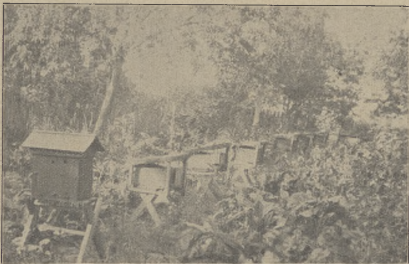
Stacja hodowli matek pszczelich w Łomiankach. Uliki mateczne (strona prawa).
