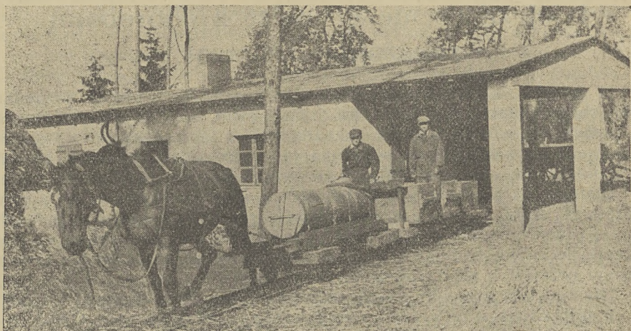
ZZD Kołuda Wielka. Nowoczesna paszarnia fermy trzody chlewnej przy okólnikowym systemie chowu.
