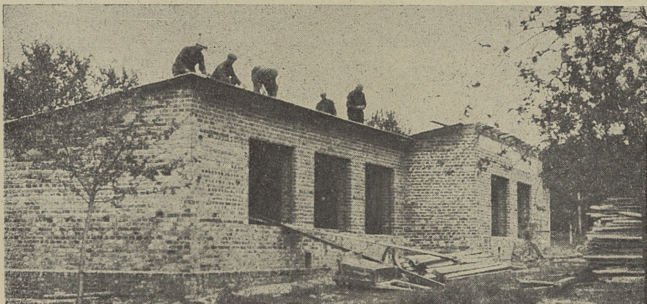
Kończymy budowę nowego kurnika na 750 niosek
