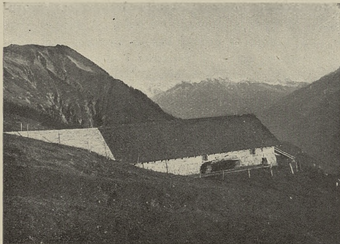
Nowoczesna bacówka z dołem gnojownicowym wzdłuż budynku i zaporą kamienną przeciwko lawinom. Hala Gummen, kanton Berner-Oberland.
