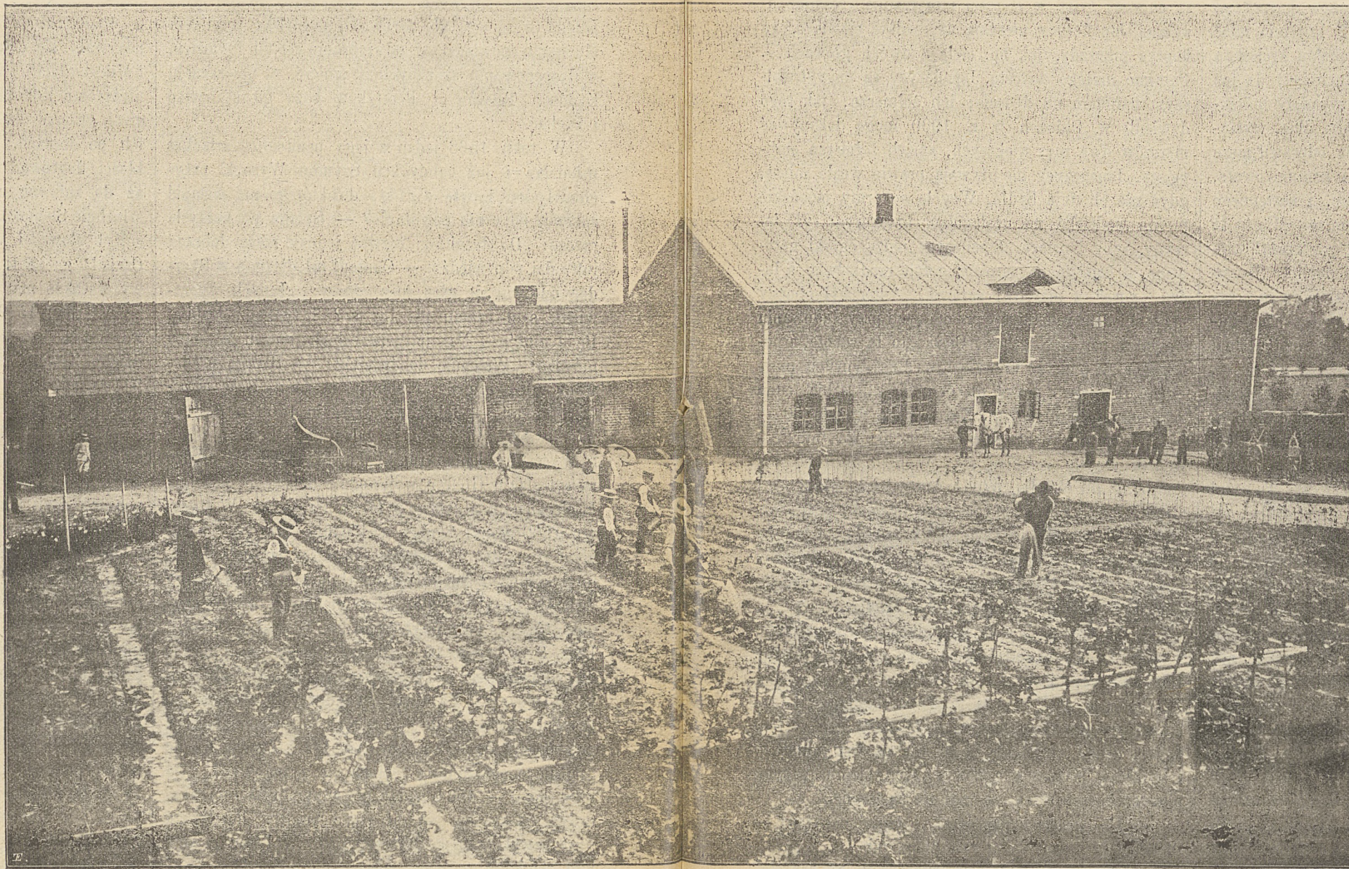
Warsztat kowalski i ślusarski w Zakładzie wychowawczym w Miejscu Piastowem
