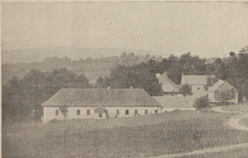
Ogólny widok zakładu w Pawlikowicach.
